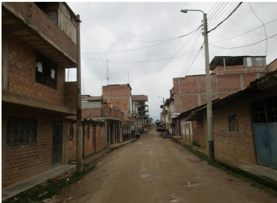
Vista de Jiron Santa Ana, Ciudad de Chachapoyas. En esta calle, la mayoría de edificaciones son de albañilería con unidades de ladrillo de arcilla cocida, donde predomina el uso de ladrillo tubular.
