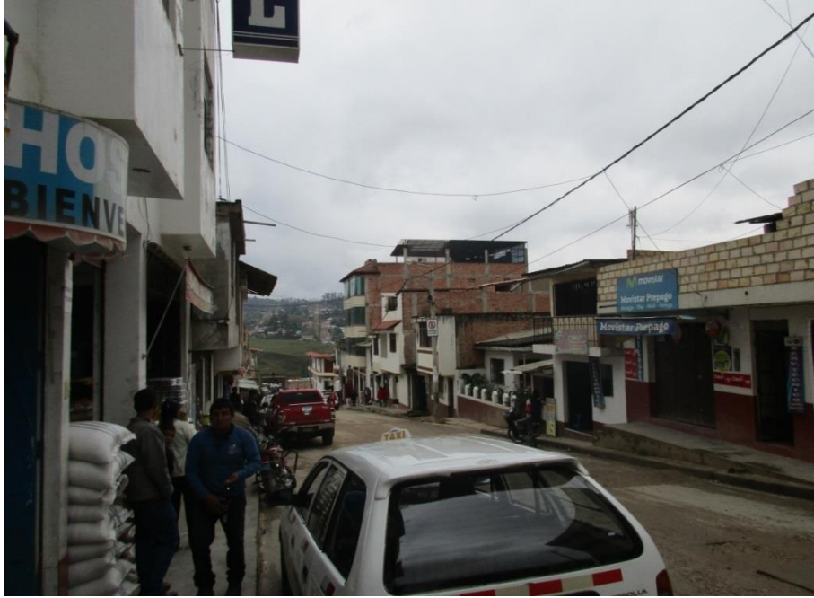
Vista de Calle Salamanca, Ciudad de Chachapoyas. En esta calle, la mayoría de edificaciones son de albañilería con unidades de ladrillo de arcilla cocida, donde predomina el uso de ladrillo tubular.
