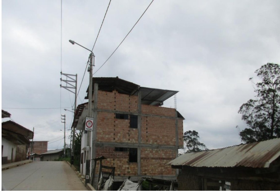
Vista de Jiron Sachapuyos, Ciudad de Chachapoyas. En esta calle, la mayoría de edificaciones son de albañilería con unidades de ladrillo de arcilla cocida, donde predomina el uso de ladrillo tubular.
