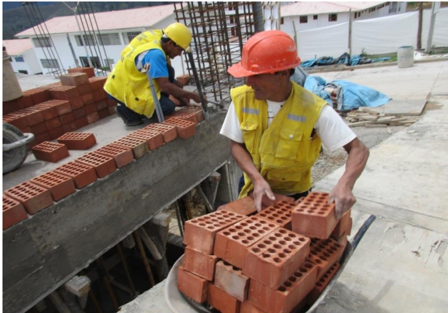
Otra Vista de Obra Ubicada en la Universidad Nacional Toribio Rodríguez de Mendoza, Ciudad de Chachapoyas. Se nota el tipo de unidad de albañilería que están usando.
