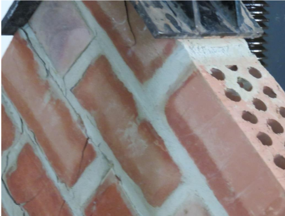
Dalla a compresión diagonal de murete de albañilería N° 03, preparada con mortero cuya arena es de la cantera San Isidro. La falla se inicia en los ladrillos de la tercera hilada.
