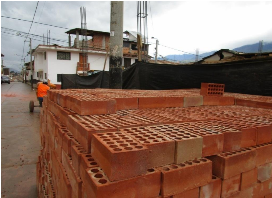
Otra vista de la obra ubicada en la Calle Santa Ana, Ciudad de Chachapoyas. En esta obra usan arena de la cantera Cerro Colorado para preparación de mortero; obra proyectada para 3 pisos, en la que usan el ladrillo de 18 huecos que se visualiza en la vista.
