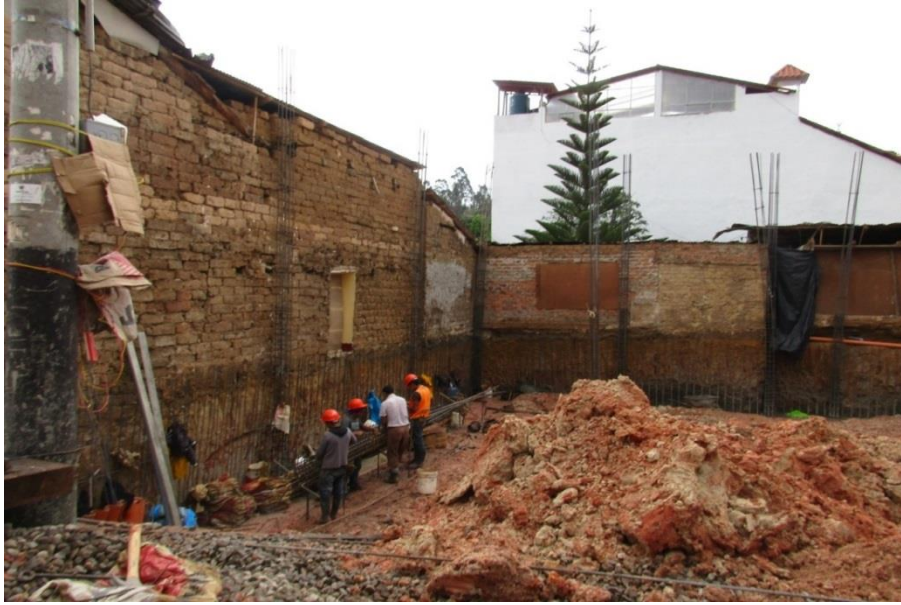
Obra ubicada en la Calle Santa Ana, Ciudad de Chachapoyas. En esta obra usan arena de la cantera Cerro Colorado para preparación de mortero; obra proyectada para 3 pisos.
