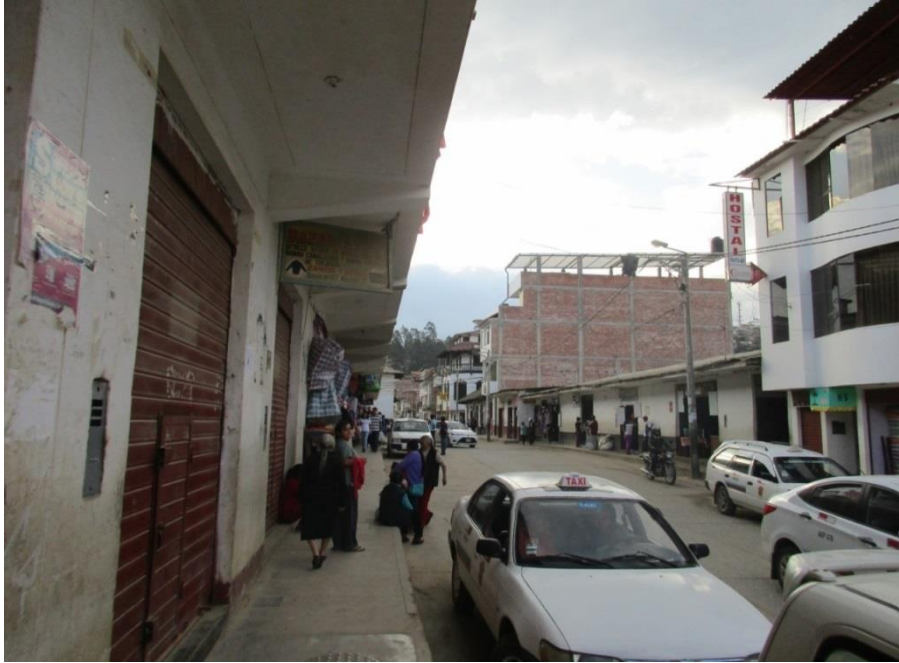
Vista de Jiron Libertad, Ciudad de Chachapoyas. En esta calle, la mayoría de edificaciones son de albañilería con unidades de ladrillo de arcilla cocida, donde predomina el uso de ladrillo tubular.
