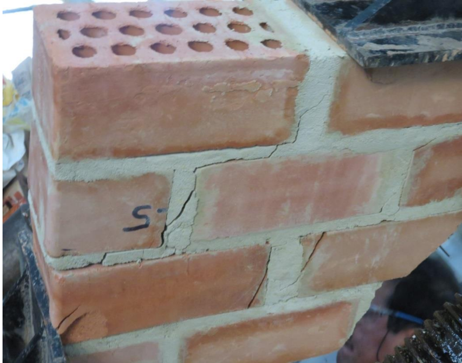
Inicio de falla a compresión diagonal de murete de albañilería N° 01, preparada con mortero cuya arena es de la cantera San Isidro. La falla se inicia en los ladrillos de la segunda hilada.
