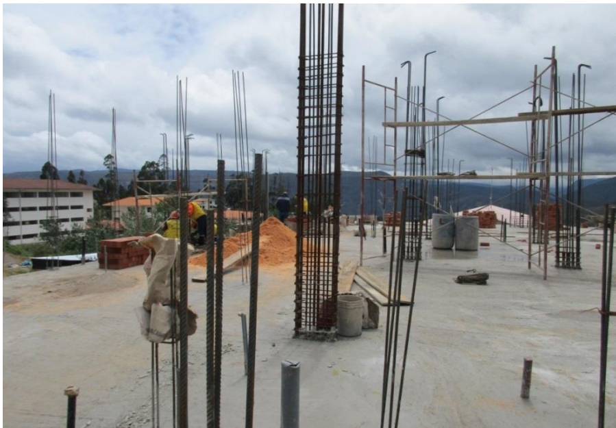
Obra Ubicada en la Universidad Nacional Toribio Rodríguez de Mendoza, Ciudad de Chachapoyas. En esta obra usan arena de la cantera Cerro Colorado para preparación de mortero; obra proyectada para 3 pisos.
