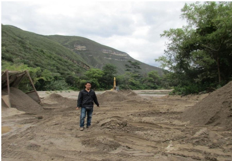
Vista de la Cantera “Rio Utcubamba” localizada en el cauce del Rio Utcubamba, en donde se Visualiza Zaranda para selección de arena gruesa.
