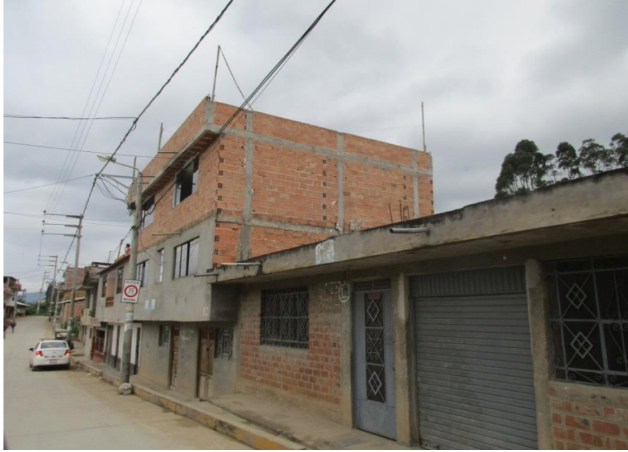
Vista de Jiron Santa Ana, Ciudad de Chachapoyas. En esta calle, la mayoría de edificaciones son de albañilería con unidades de ladrillo de arcilla cocida, donde predomina el uso de ladrillo tubular.
