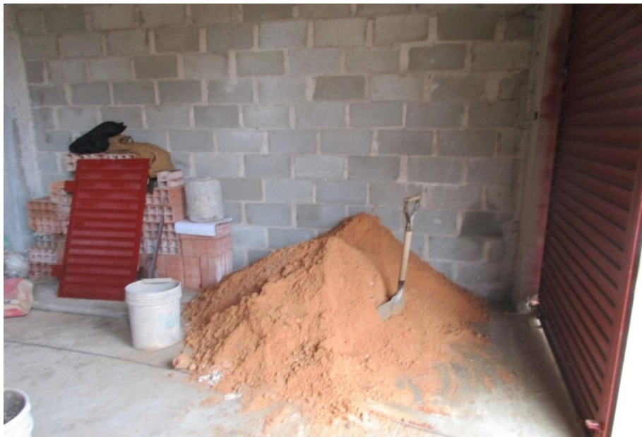
Otra vista de obra ubicada en Jr. Grau, ciudad de Chachapoyas. Se observa la arena de cantera Cerro Colorado y el tipo de unidad de albañilería usado en el 1° nivel.
