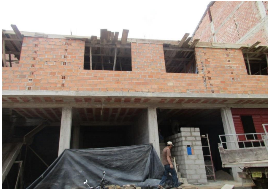
Obra Ubicada en Jr. Grau, ciudad de Chachapoyas. En esta construcción están usando arena de cantera Cerro Colorado para preparación de mortero; Obra proyectada para 4 pisos, donde en el 1° piso están usando ladrillo hueco de concreto y en el 2° nivel usan ladrillo pandereta (tubular).
