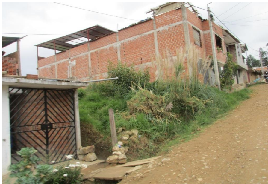
Vista de Jiron Santa Ana, Ciudad de Chachapoyas. En esta calle, la mayoría de edificaciones son de albañilería con unidades de ladrillo de arcilla cocida, donde predomina el uso de ladrillo tubular.
