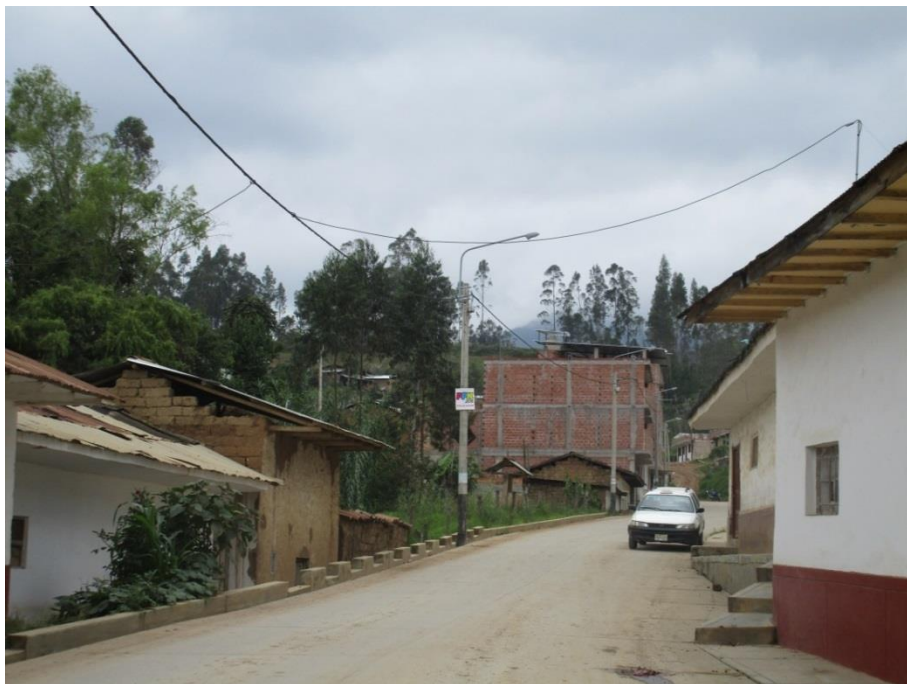
Vista de Jiron Triunfo, Ciudad de Chachapoyas. En esta calle, la mayoría de edificaciones son de albañilería con unidades de ladrillo de arcilla cocida, donde predomina el uso de ladrillo tubular.
