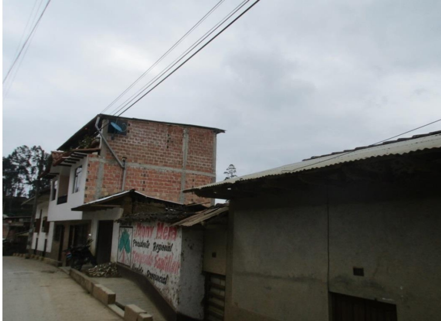
Vista de Jiron Sachapuyos, Ciudad de Chachapoyas. En esta calle, la mayoría de edificaciones son de albañilería con unidades de ladrillo de arcilla cocida, donde predomina el uso de ladrillo tubular.
