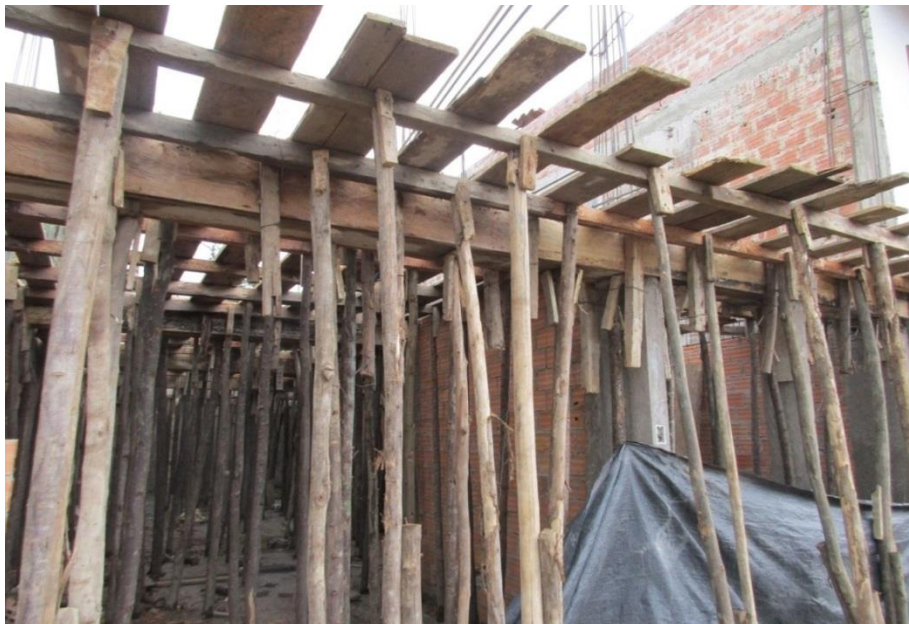
Obra Ubicada en Jr. La Merced, ciudad de Chachapoyas. En esta construcción están usando arena de cantera Rio Utcubamba para preparación de mortero; obra proyectada para 4 pisos, donde usan ladrillo pandereta (tubular) desde el primer nivel.
