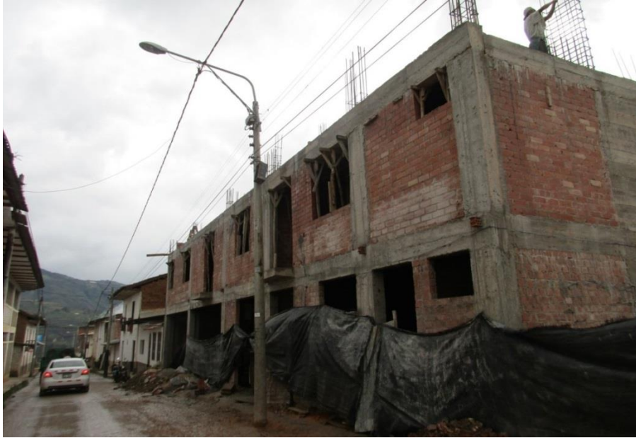
Obra ubicada en la Calle Santo Domingo, Ciudad de Chachapoyas. En esta obra usan arena de la cantera Cerro Colorado para preparación de mortero; obra proyectada para 3 pisos.
