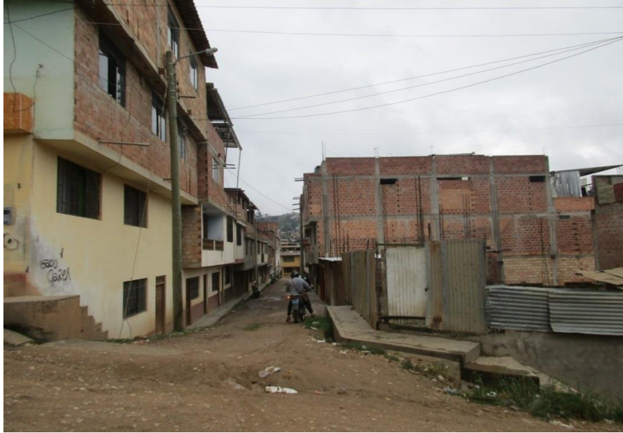
Vista de Pasaje Santa Cecilia, Ciudad de Chachapoyas. En esta calle, la mayoría de edificaciones son de albañilería con unidades de ladrillo de arcilla cocida, donde predomina el uso de ladrillo tubular.
