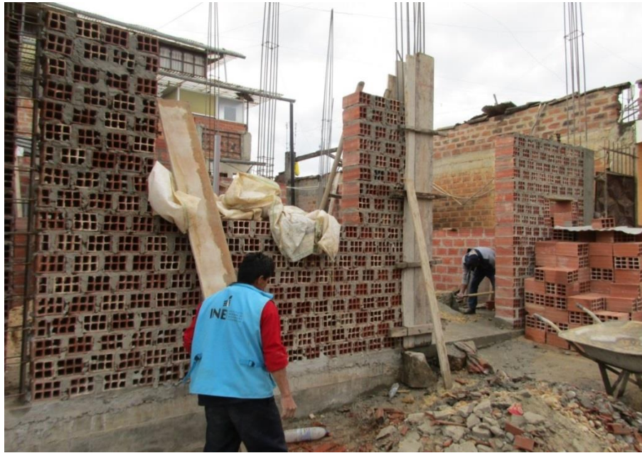
Obra Ubicada en Jr. La Merced, ciudad de Chachapoyas. En esta construcción están usando arena de cantera San Isidro para preparación de mortero; Obra proyectada para 3 pisos, donde usan de ladrillo pandereta (tubular) desde el primer nivel.
