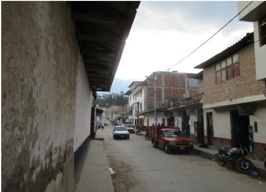
Vista de Jiron Ayacucho, Ciudad de Chachapoyas. En esta calle, la mayoría de edificaciones son de albañilería con unidades de ladrillo de arcilla cocida, donde predomina el uso de ladrillo tubular.
