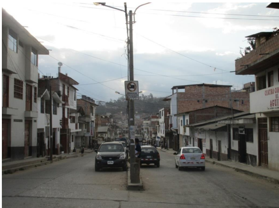
Vista del Jiron Libertad, Ciudad de Chachapoyas. En esta calle, la mayoría de edificaciones son de albañilería con unidades de ladrillo de arcilla cocida, donde predomina el uso de ladrillo tubular.
