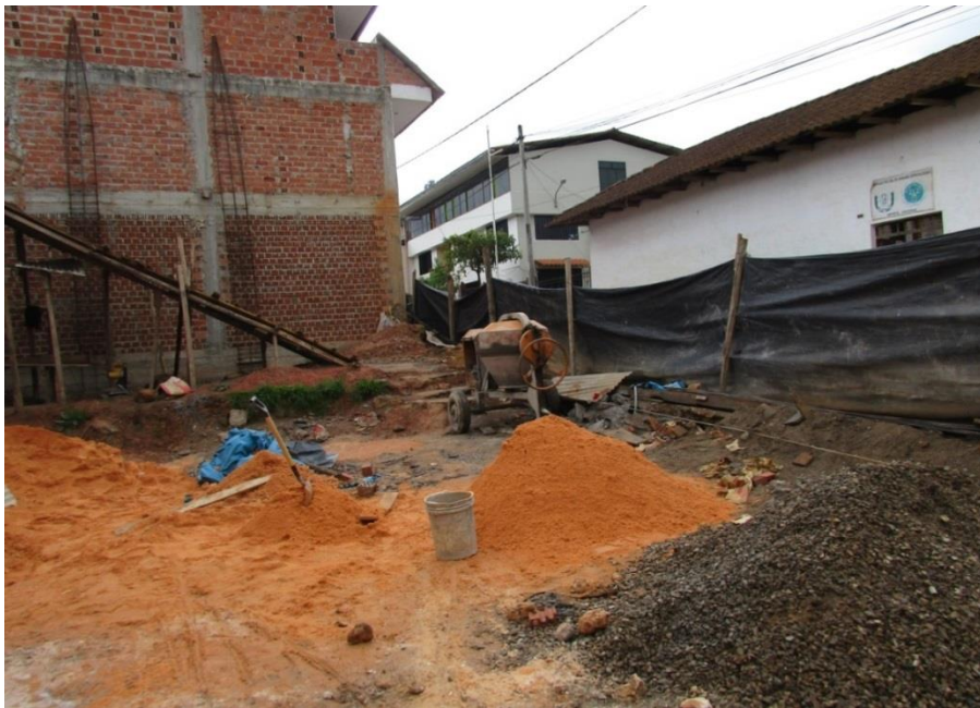
Otra vista de la obra ubicada en la Calle Santo Domingo, Ciudad de Chachapoyas. Se visualiza la arena de la cantera Cerro Colorado.
