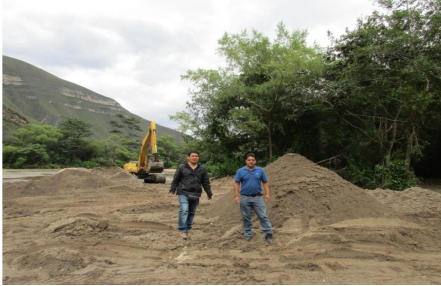
Vista de la Cantera “Rio Utcubamba” localizada en el cauce del Rio Utcubamba, en donde se explota agregados, entre ellos arena gruesa.
