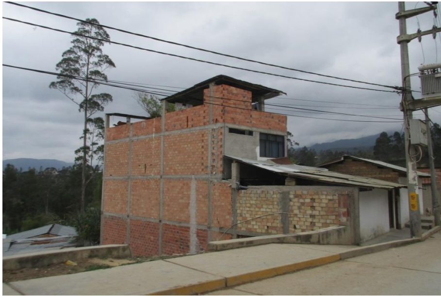
Vista de Jiron Triunfo, Ciudad de Chachapoyas. En esta calle, la mayoría de edificaciones son de albañilería con unidades de ladrillo de arcilla cocida, donde predomina el uso de ladrillo tubular.
