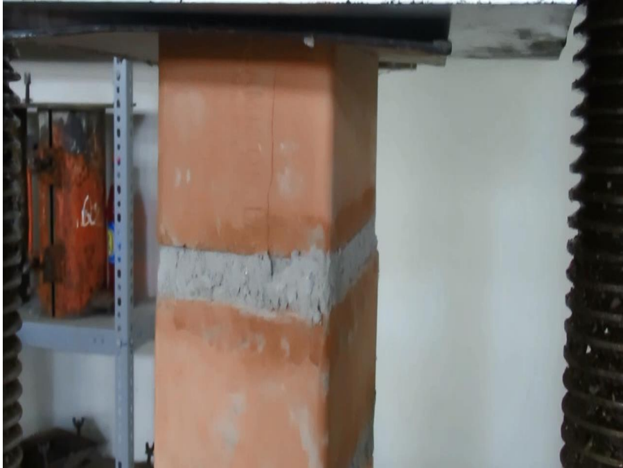
Inicio de falla a compresión axial de pila de albañilería N° 02, preparada con mortero cuya arena es de la cantera Rio Utcubamba. La falla se inicia en el ladrillo superior.
