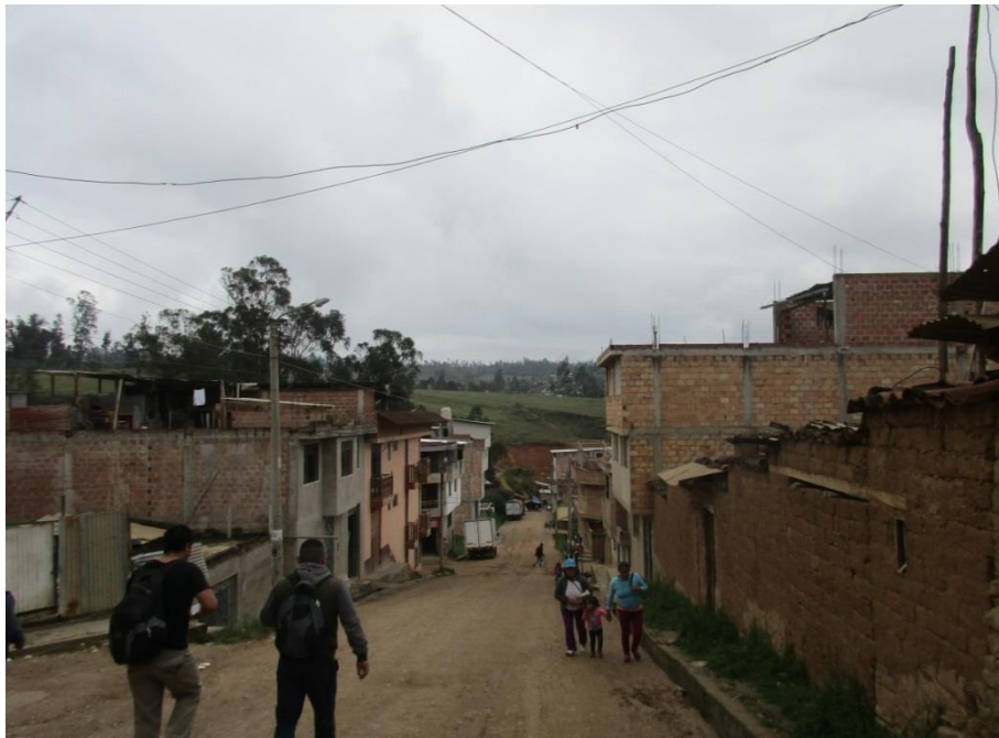
Vista de Jiron Recreo, Ciudad de Chachapoyas. En esta calle, la mayoría de edificaciones son de albañilería con unidades de ladrillo de arcilla cocida, donde predomina el uso de ladrillo tubular.
