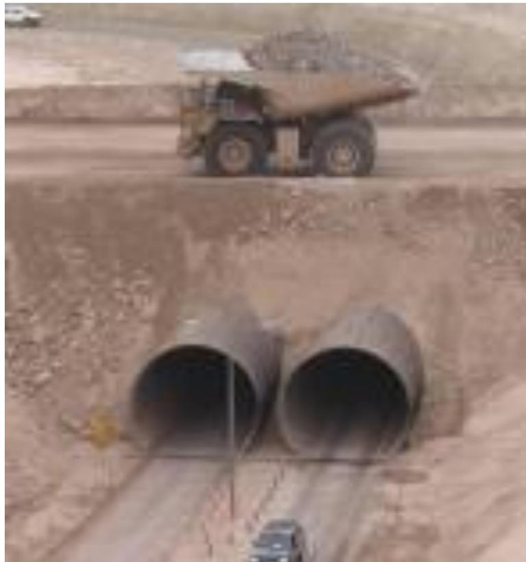
Figure 7: Imagen de alcantarilla de gran Luz instalada en la mina cerro verde
