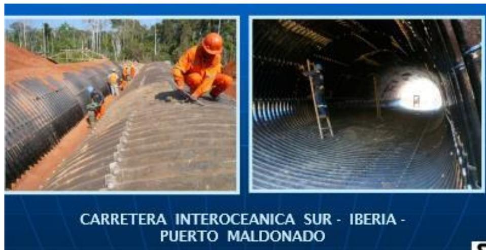
Figure 5: Imagen de ensamblado de alcantarilla de Gran Luz en carretera interoceánica Sur
