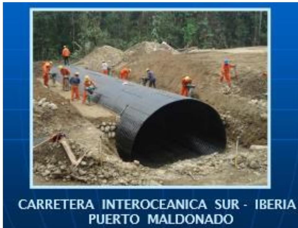
Figure 4: Imagen de Alcantarilla Súper Spam en Carretera Interoceánica Sur – Iberia Puerto Maldonado
