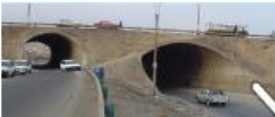
Figure 6: Imagen de alcantarilla de gran Luz en Zapallal, utilizada como puente
