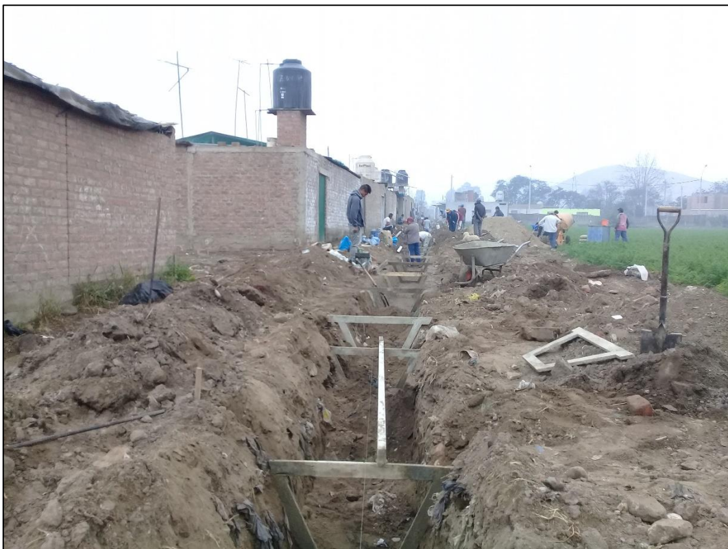
Fotografía 8. Área de trabajo de encofrado y área de trabajo de vaciado de concreto (al fondo).
