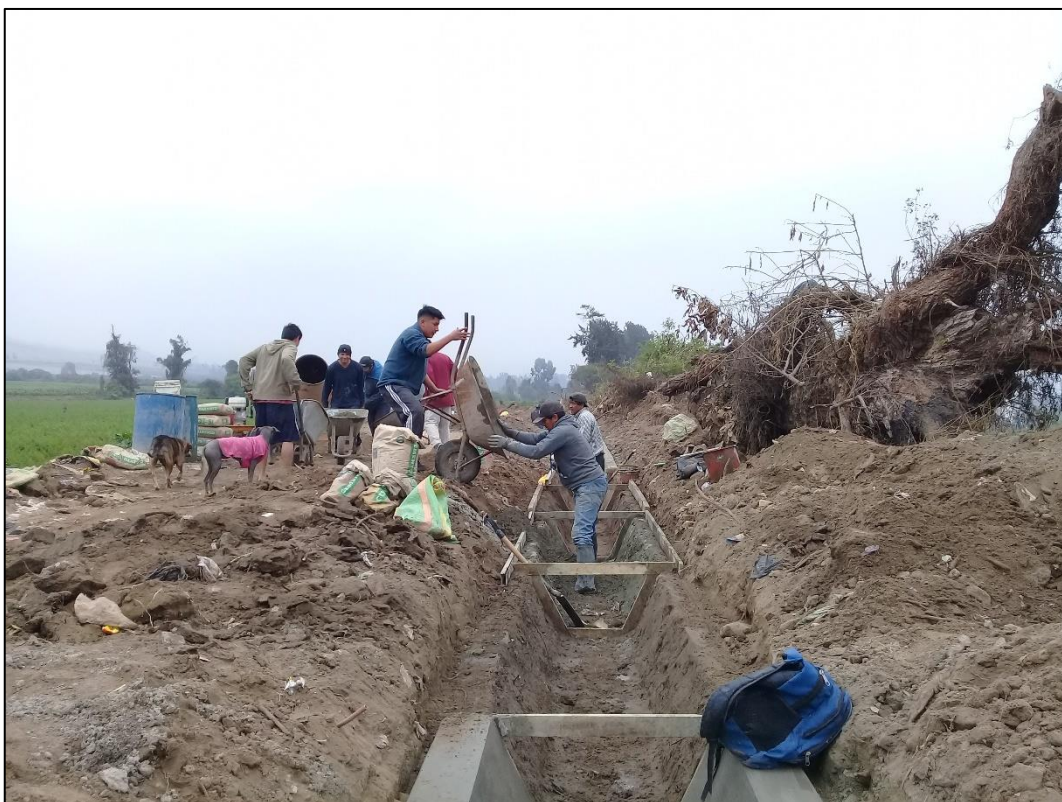
Fotografía 16. Un peón apoyando al operario en el vaciado de concreto al canal.
