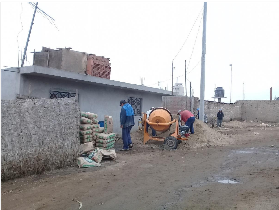
Fotografía 2. Un oficial y dos peones preparando concreto.
