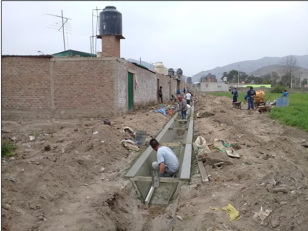
Fotografía 11. Nueve operarios realizando trabajos productivos, un oficial y seis peones descansando.
