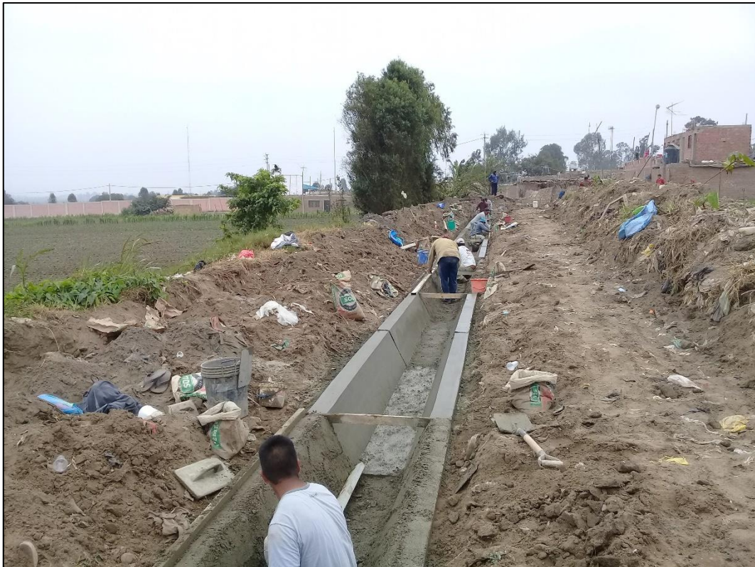
Fotografía 15. Operarios realizando el trabajo de regleado y pañeteo en las paredes del canal.
