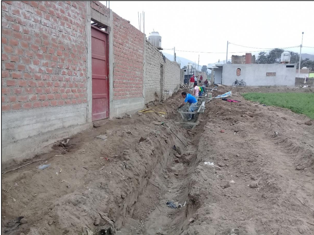
Fotografía 5. Dos operarios esperando para el vaciado de concreto.
