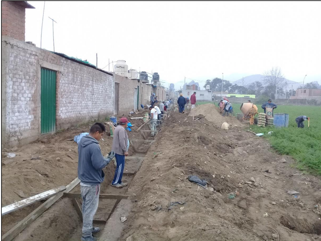
Fotografía 9. Dos operarios esperando para el vaciado de concreto.
