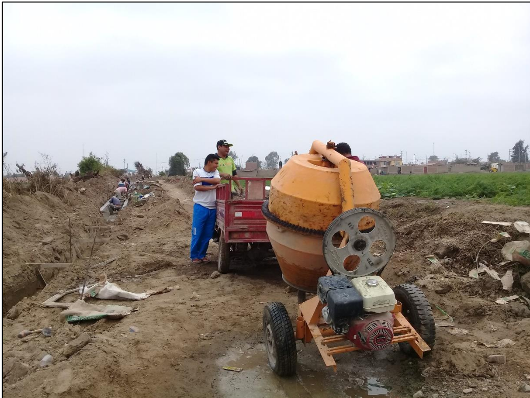
Fotografía 19. Traslado de la mezcladora de concreto hacia el almacén.
