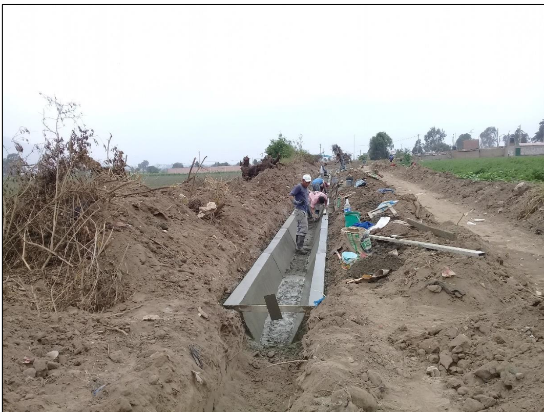
Fotografía 18. Un operario mirando y tres operarios realizando frotachado y enlucido.
