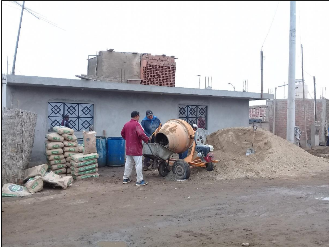
Fotografía 3. Un oficial y un peón llenando concreto a la carretilla y dos peones esperando.
