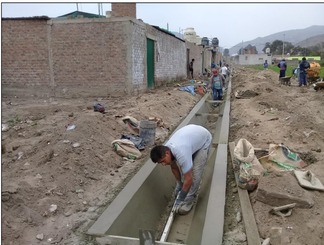
Fotografía 10. Operario realizando el regleado en la base del canal.
