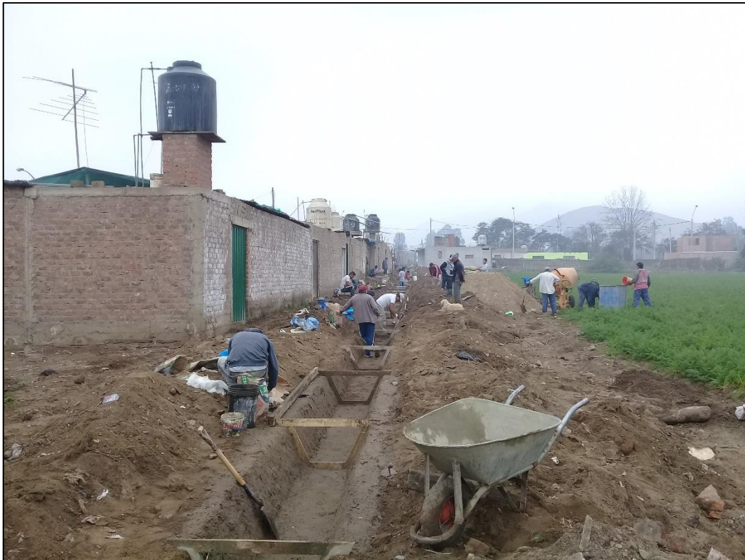
Fotografía 7. Un oficial y un peón llenando agua al bidón, cinco peones parados y nueve operarios esperando para el vaciado de concreto.
