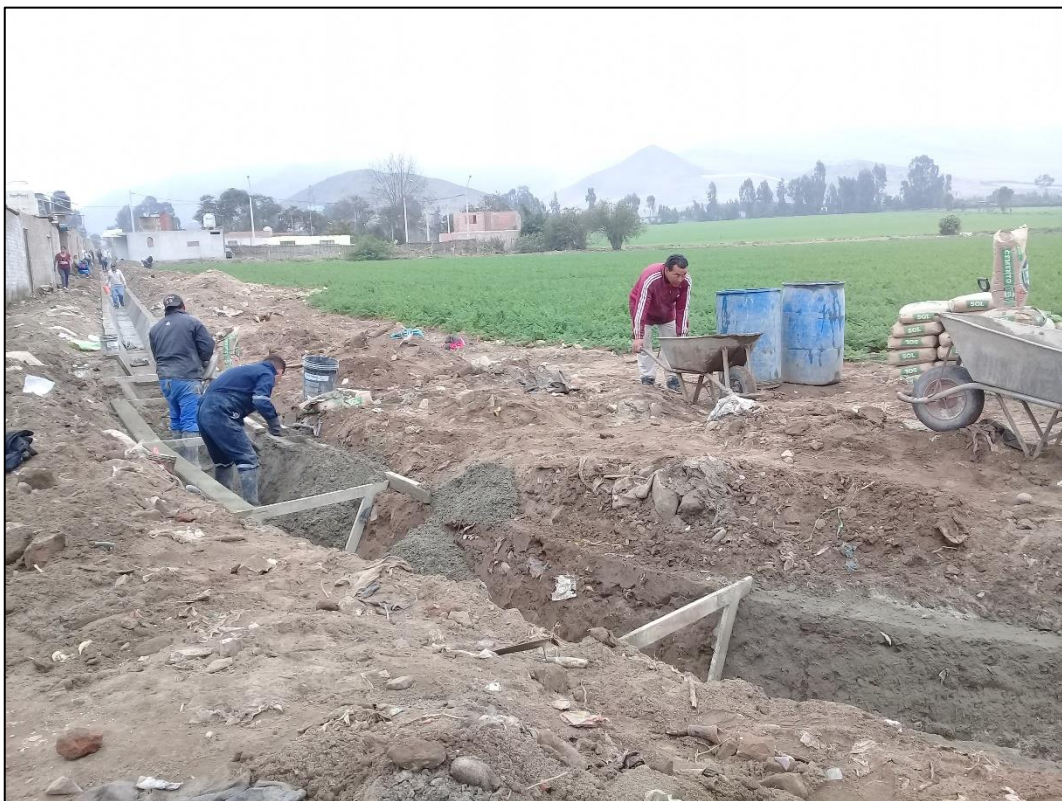
Fotografía 14. Dos operarios realizando el trabajo de pañeteo y un peón trasladando concreto.
