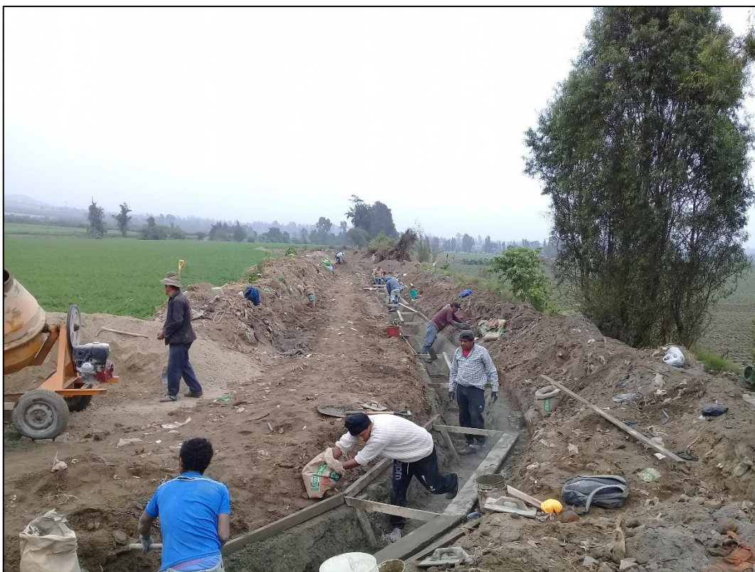
Fotografía 12. Operarios realizando los trabajos de pañeteo, espolvoreado y frotachado.
