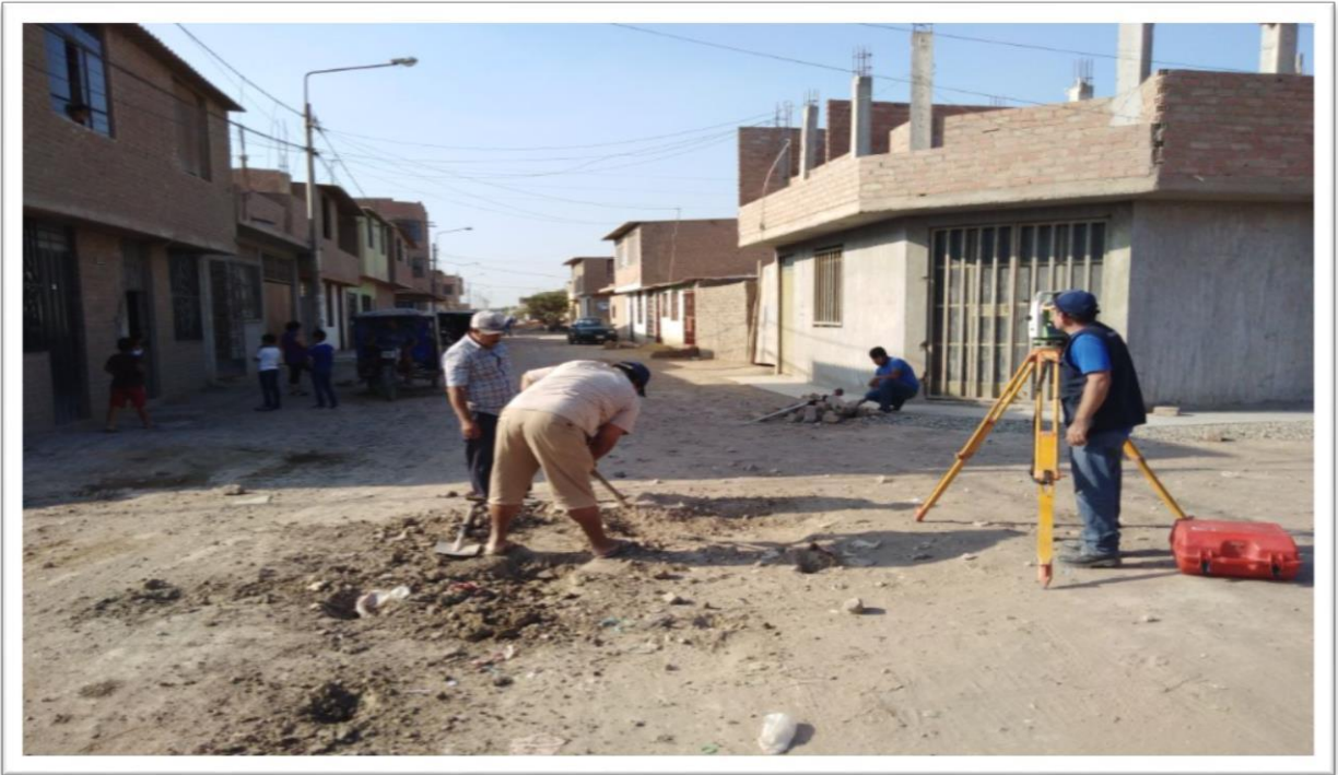
Figura 12 buscando los buzones tapados para registrar punto con la estacion total leica
