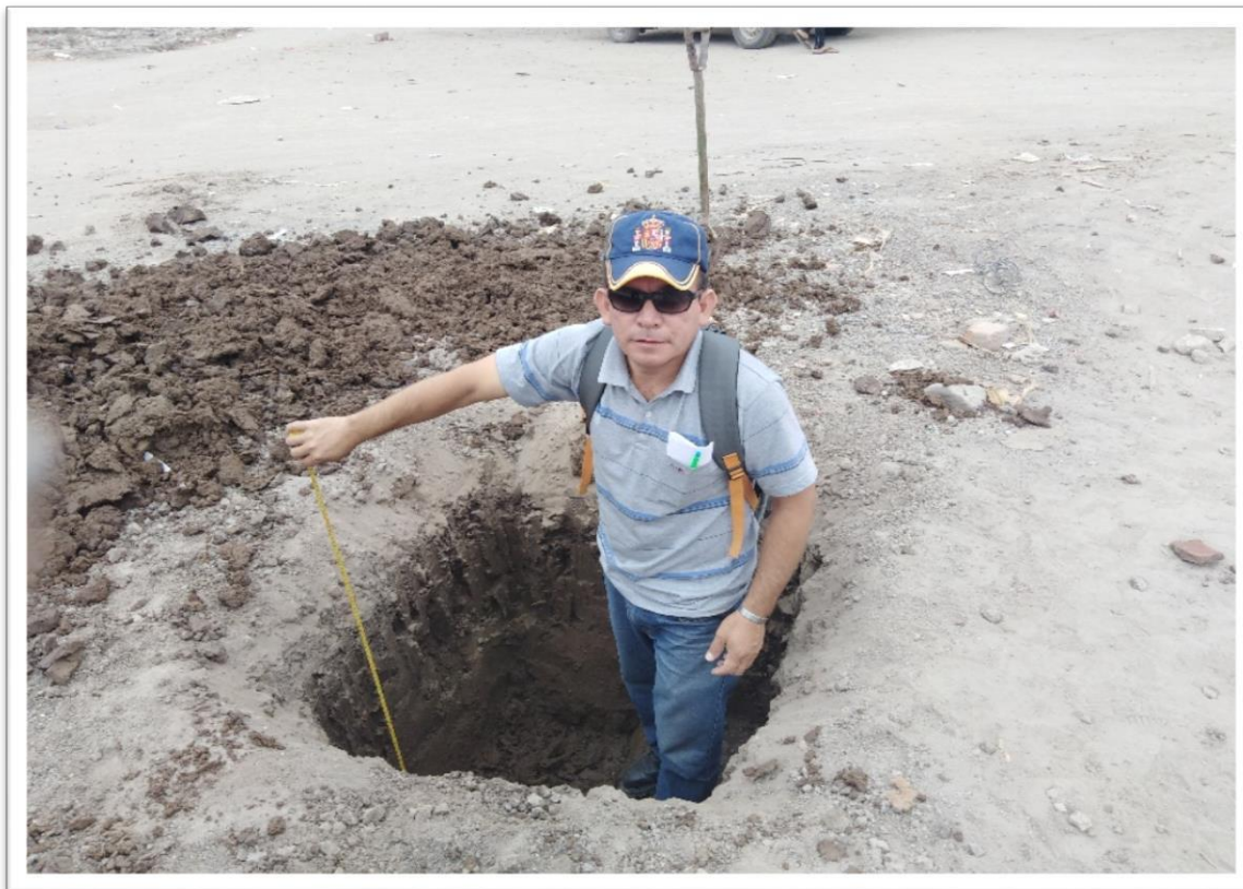
Figura 16 Midiendo profundidad de la calicata
