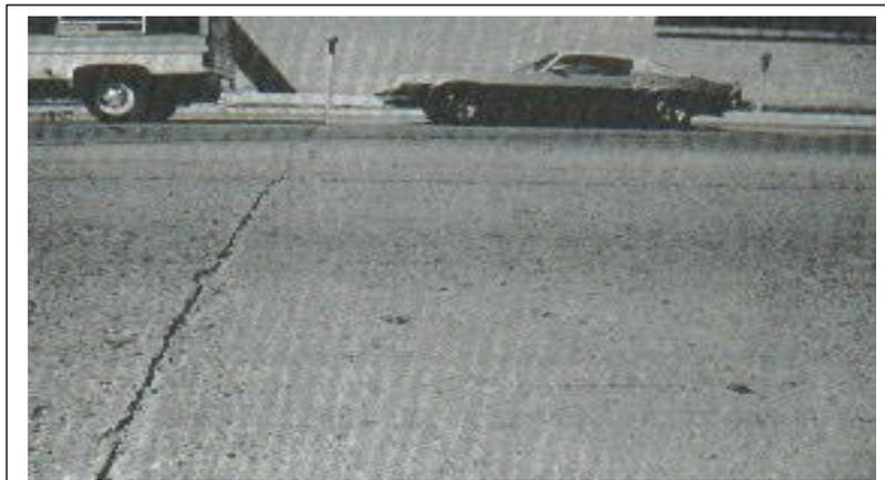
Descascaramiento de junta de baja severidad.
