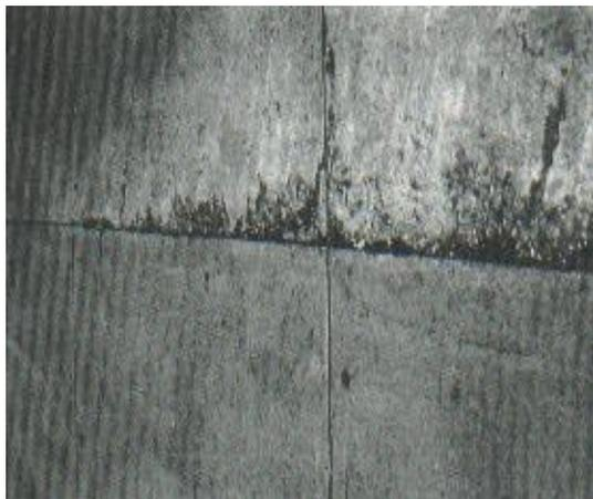
Descascaramiento de junta de severidad media.
