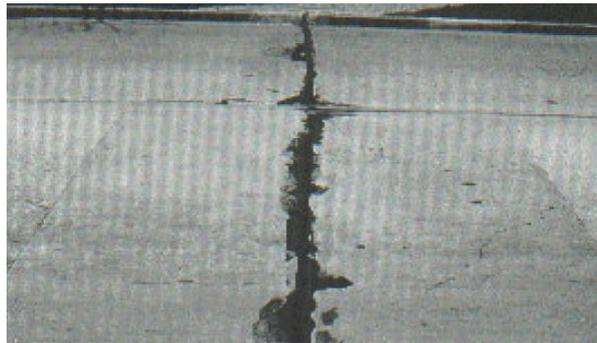
Daño del sello de junta de baja severidad
