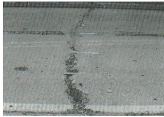
Grietas lineales de alta severidad en losa de concreto simple.
