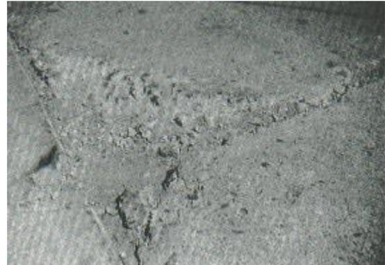
Descascaramiento de esquina de alta severidad.
