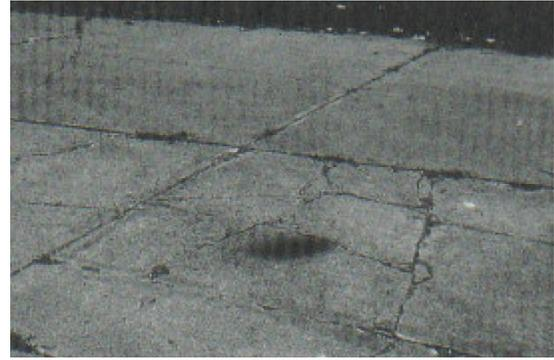
Losa dividida de alta severidad
