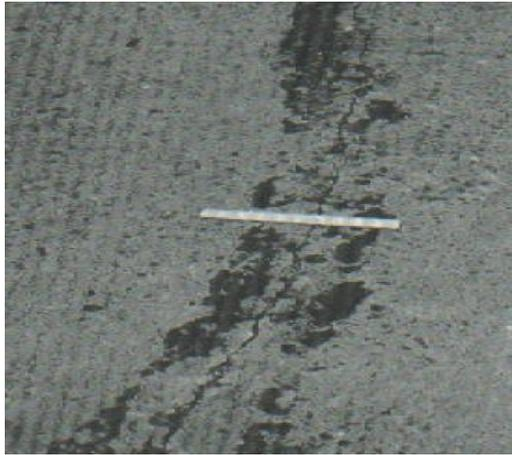
Grietas lineales de baja severidad en losa de concreto simple.
