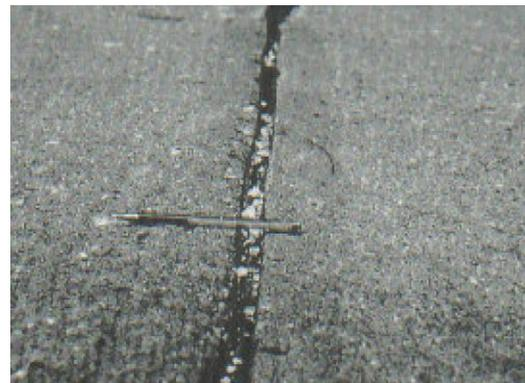
Daño del sello de junta de alta severidad
