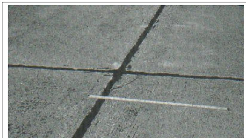
Descascaramiento de esquina de baja severidad.
