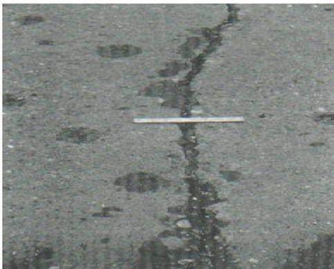
Grietas lineales de severidad media en losa de concreto reforzado.
