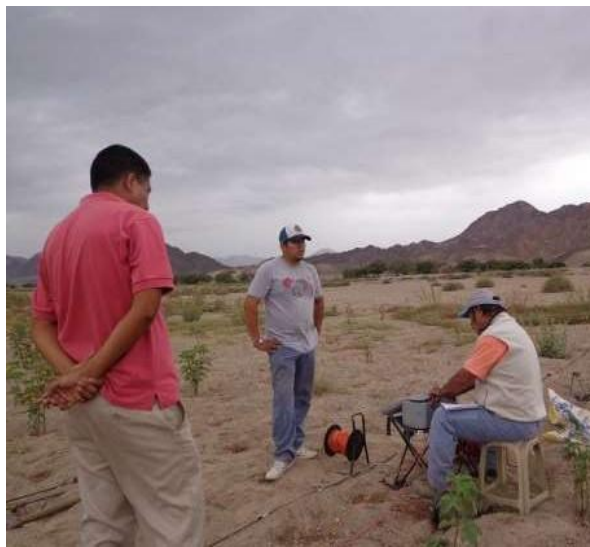
Vista de ejecución de sondaje eléctrico 2
