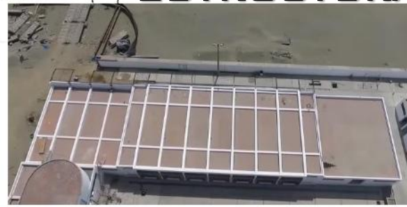
Las vigas se muestran resaltadas al exterior, ya que en el interior se muestran empotradas.
