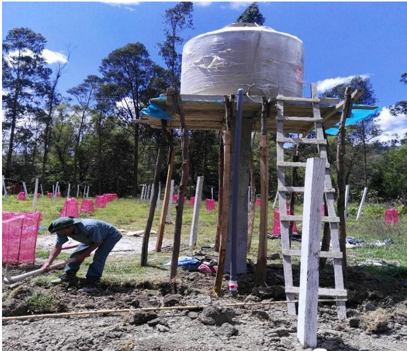
Figura 35. Vista de la instalación de los tanques elevados en una de las parcelas en el cultivo de granadilla en el Centro Poblado de Yuracyacu - Chota.
