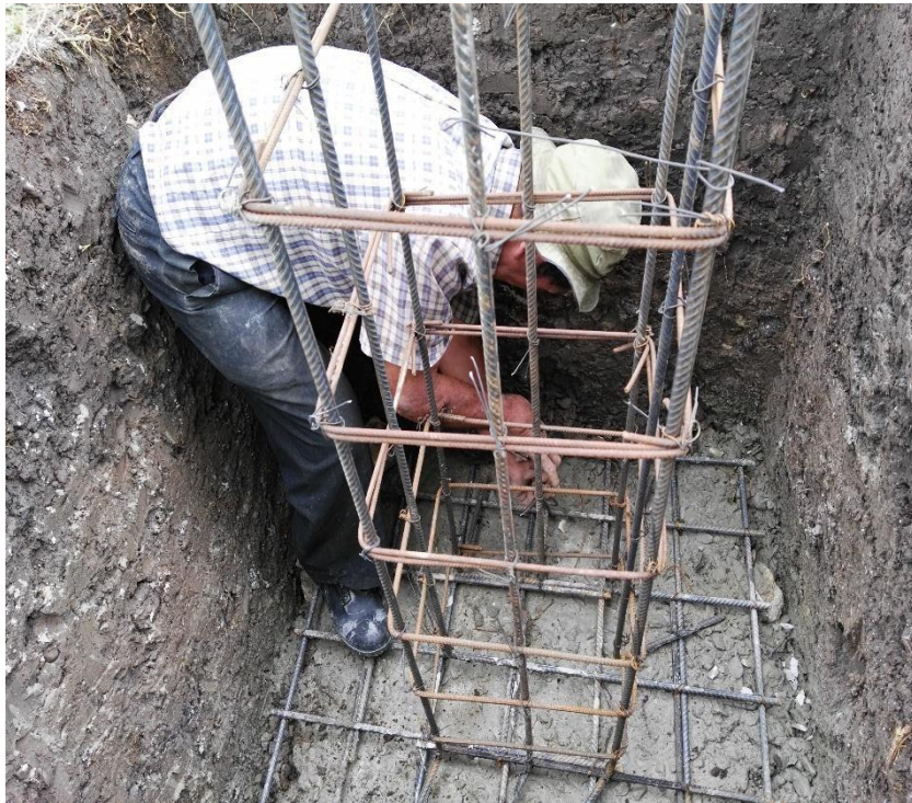
Figura 34. Construcción de los soportes para los tanques elevados en el centro poblado de Yuracyacu - Chota.
