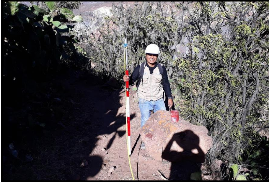
Figura 6: Replanteo de progresiva en trocha carrozable
