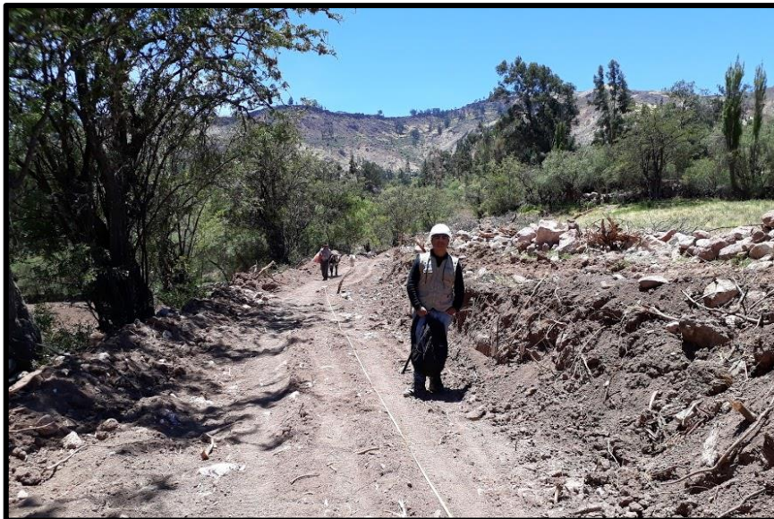
Figura 5: Se evidencia una superficie de rodadura deteriorada
