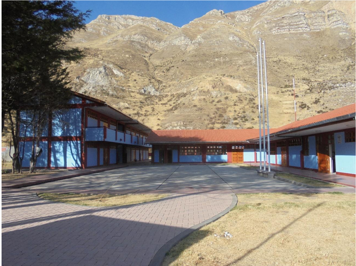
Instalaciones del Glorioso Colegio "10 de Abril de 1882" Llocllapampa
