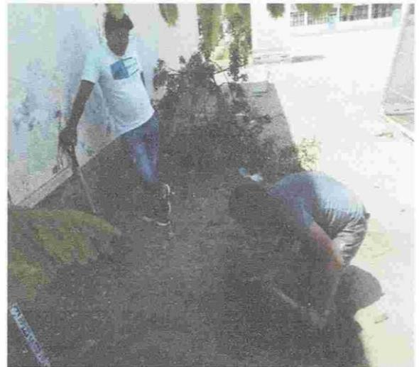
En la imagen se observa el inicio de la excavación de calicata para la extracción de muestra
