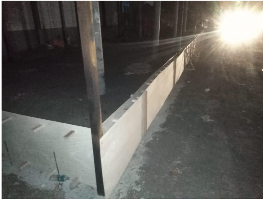
Anexo 10. Tubo metálico en sobre base de cemento
