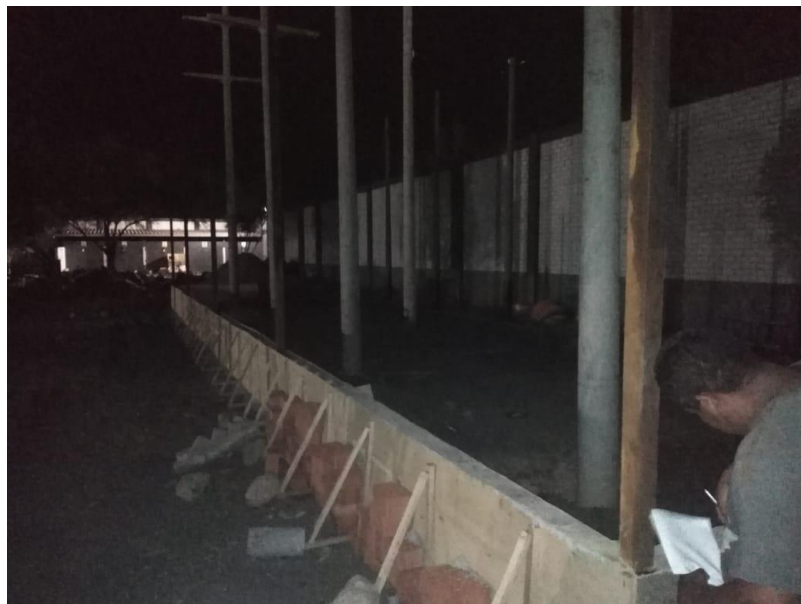
Anexo 11. Tubos metálicos en contra base de cemento
