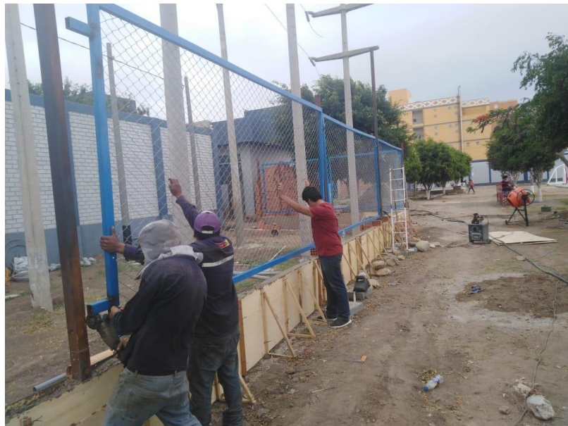
Anexo 15. Primer lado de cerco perimétrico
