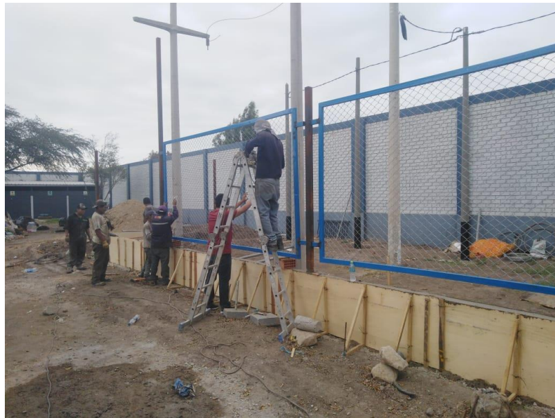
Anexo 16. Primer lado de cerco perimétrico
