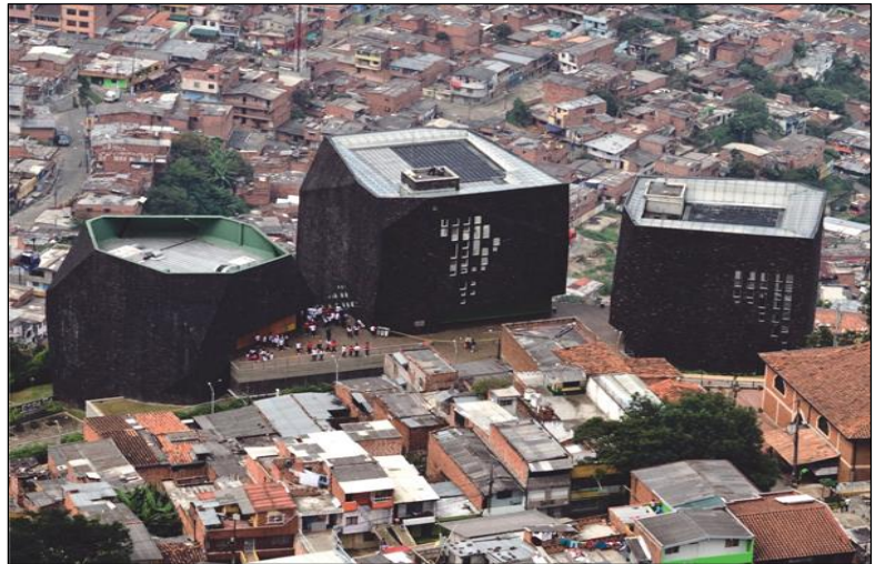
Imagen 074: Ventilación e iluminación de los bloques Fuente: www. captaincano.com
