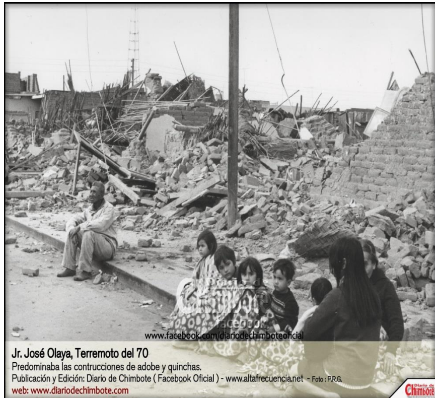
Imagen 027: Viviendas del Jr. José Olaya destruidos por el terremoto Fuente: www.diariodechimbote.com
