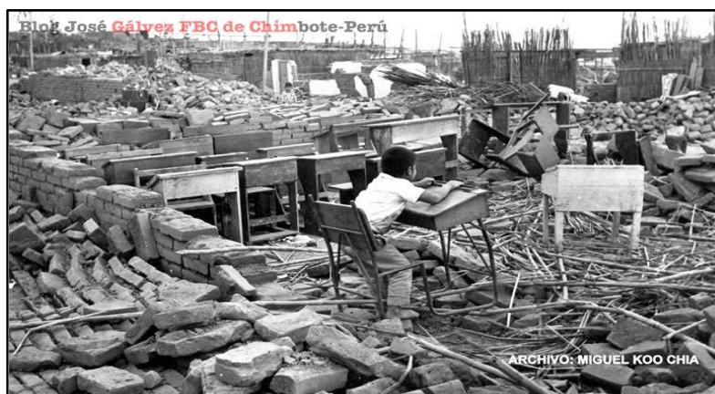
Imagen 025: Escuela ubicada en el A.H. San Pedro Totalmente destruida
