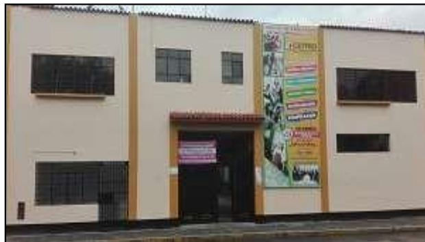
Fotografía 01: vista frontal del Cetpro
