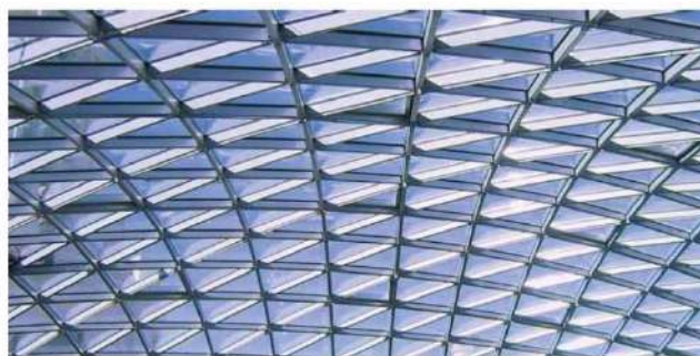
Imagen 2. Malla espacial formada por una sola capa
