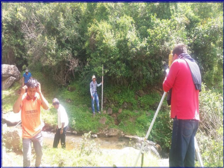
En esta vista se aprecia al personal técnico, realizando los trabajos de levantamiento topográfico de la zona del
