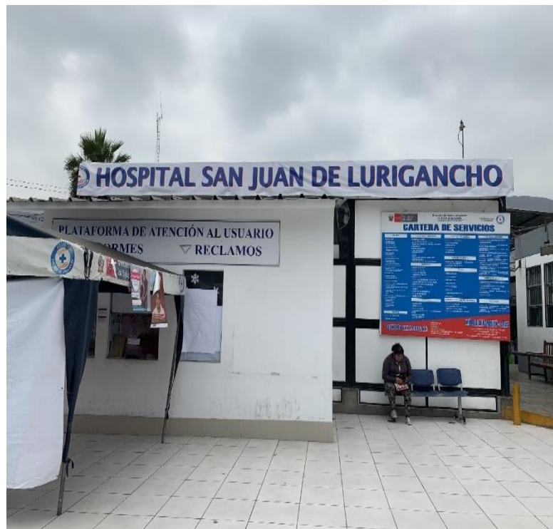
Figura N° 7 Hospital San Juan de Lurigancho
