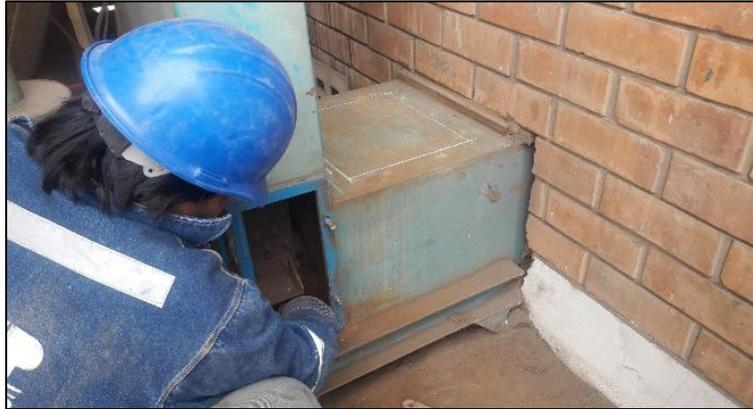
Figura N° 25 Limpieza Interna de Cangilones Inferiores.
