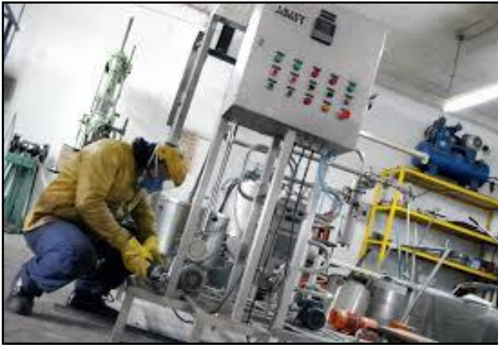
Figura 26. Trabajos Después de la Implementación del Sistema de Gestión de Seguridad Fuente: Elaboración propia.
