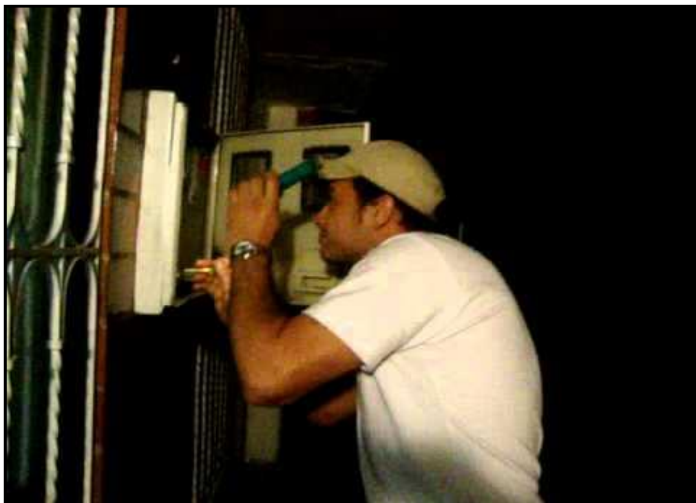
Figura 24. Trabajos Antes de la Implementación del Sistema de Gestión de Seguridad
