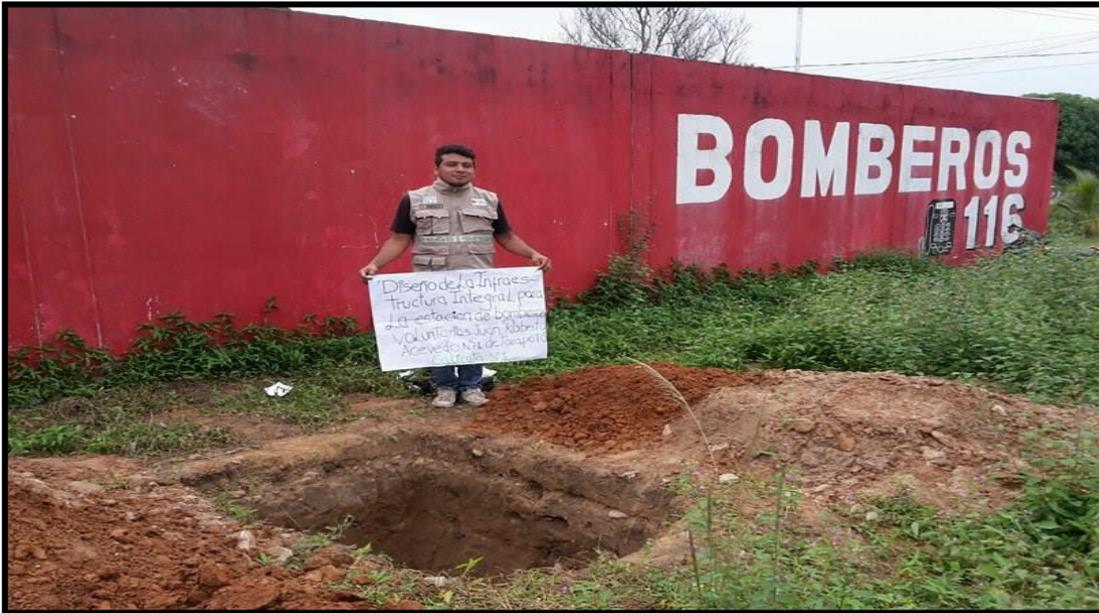
Se procede a ejecutar la calicata para luego realizar los ensayos en el laboratorio de mecánica de suelos y conocer el tipo de suelo.
