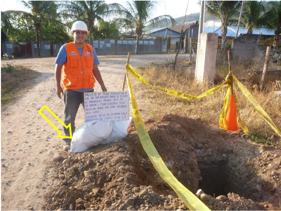
SE OBSERVA AL TESISISTA BACH. ING. CIVIL, REALIZANDO LA EXTRACCIÓN Y MUESTREO DEL SUELO PARA LOS ENSAYOS DE PROCTOR MODIFICADO, CBR, CALICATA EXCAVADA N°01 – JR. LA UNION CDRA N°01-L/IZQ.
