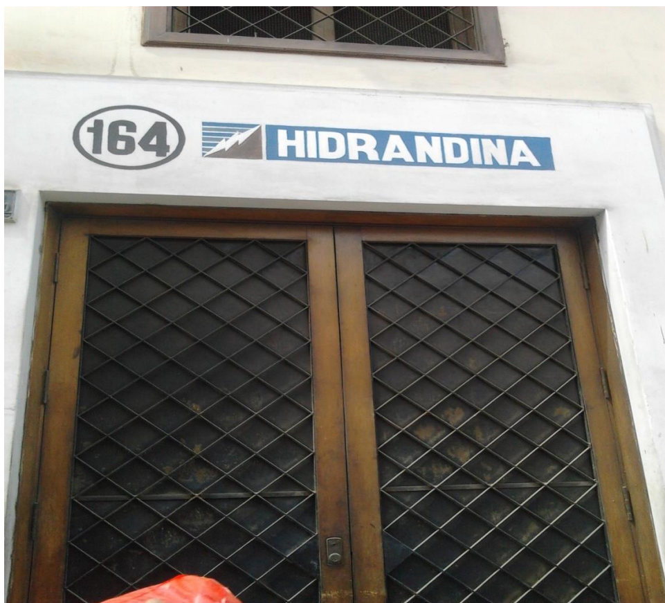
Fotos de la subestación HI-164 de Hidrandina (punto de diseño)
