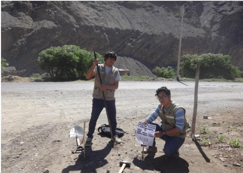
Foto 04: Excavación de calicata C-7 progresiva 7+000
