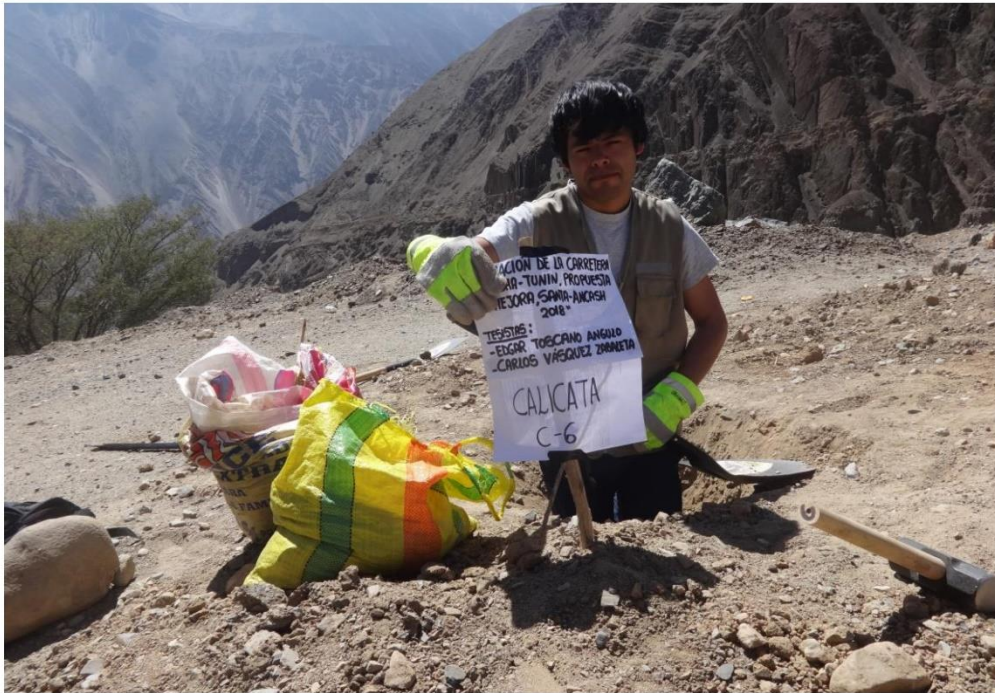
Foto 03: Excavación de calicata C-6 progresiva 6+000
