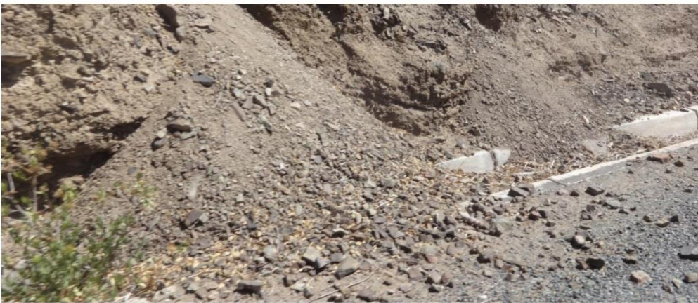
Foto 01: Cunetas existentes y parcialmente obstruido
