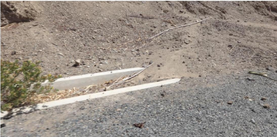
Foto 01: Cunetas existentes y parcialmente obstruido
