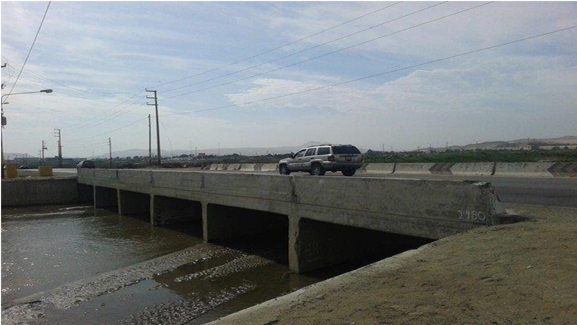
Foto N°01: Vista longitudinal del puente del río Lacramarca.
