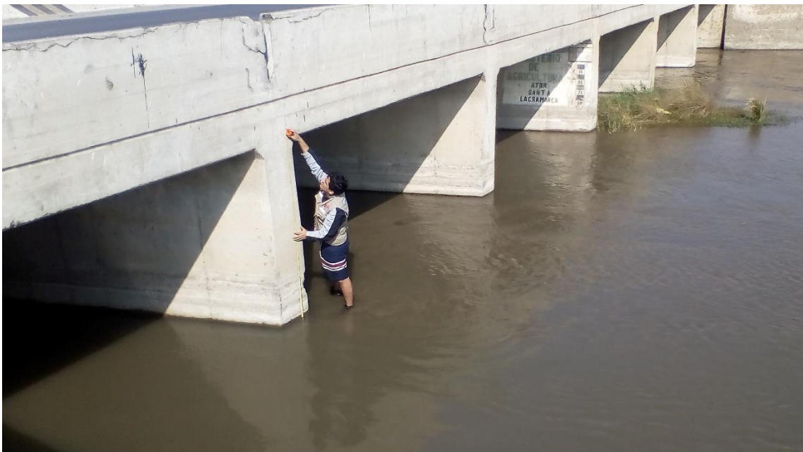
Foto N°04: Realizando las mediciones en el Puente de estudio
