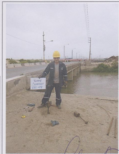
Foto N°06: Vista del DPL-02, de 0.00 a 2.00m de profundidad, presencia de arena mal graduada, con raíces, materia orgánica y bloques de roca. De 2.00m a 3.00m de profundidad presencia de arenas mal graduada (SP), suelta, húmeda a saturado de color beige claro a beige oscuro. De 3.00m a 6.90m de profundidad presencia de arenas mal graduada (SP), suelta a compacta, saturado de color beige oscuro El nivel freático se registró a los 2.20m de profundidad.
