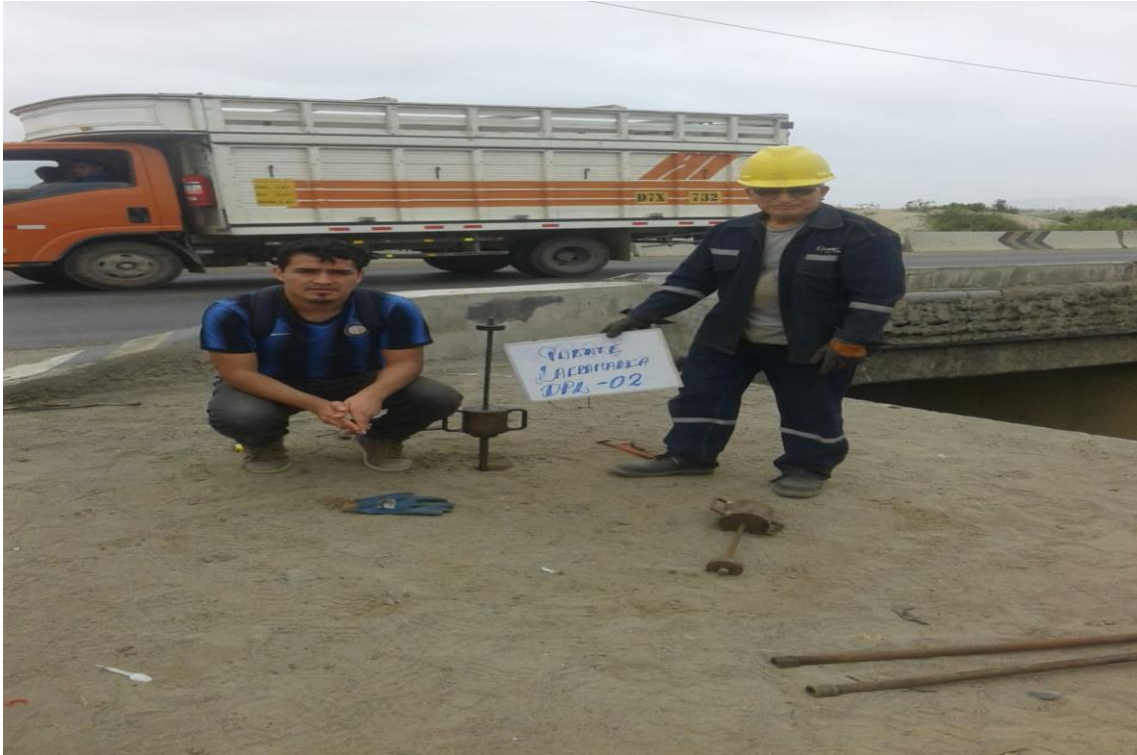
Foto N°03: Realizando prueba de DPL en la zona de estudio
