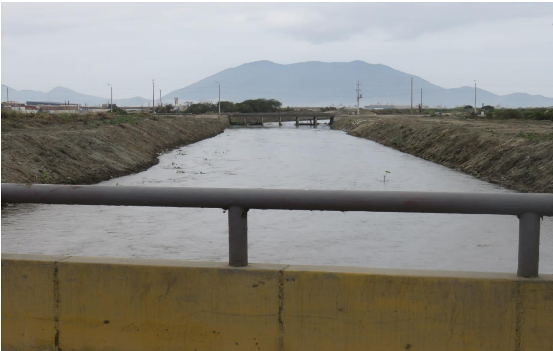
Foto N°02: Vista aguas abajo del Puente del río Lacramarca
