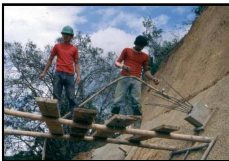
Figura 17. Operario inyectando concreto.
