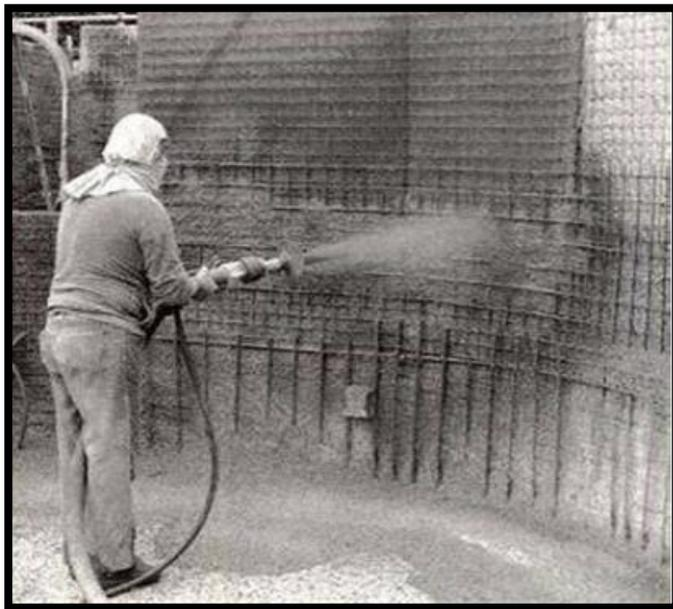
Figura 16. Operario aplicando concreto lanzado.
