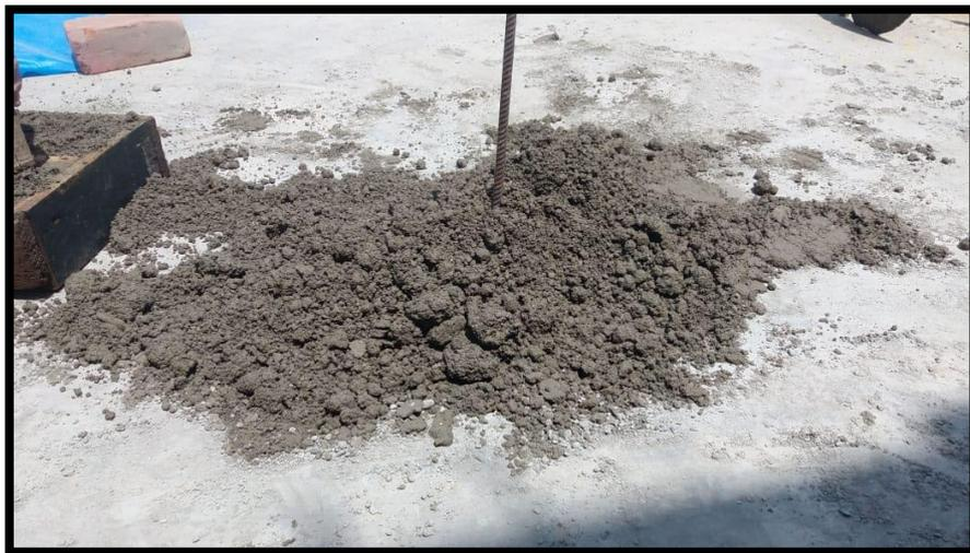
Figura 109. Mezcla de concreto lista para utilizar en la elaboración del ladrillo.
