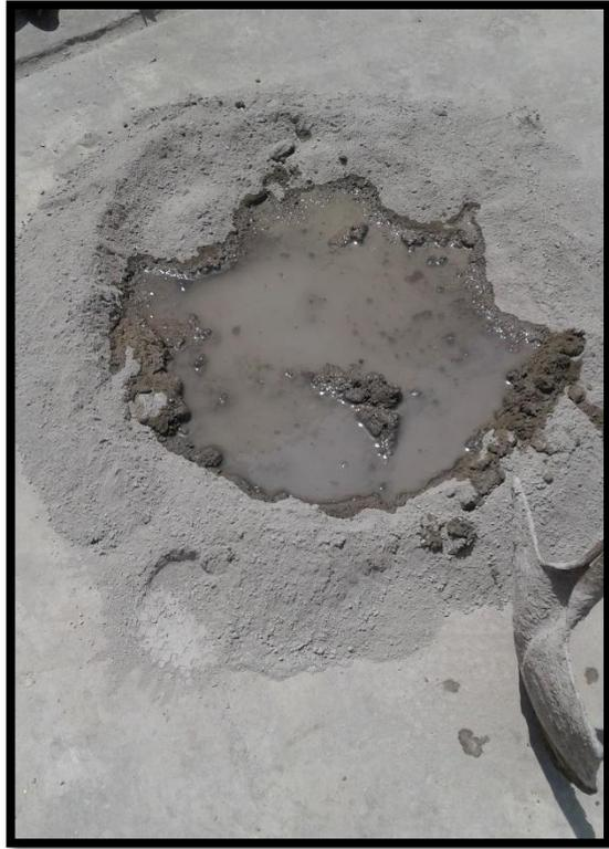
Figura 108. Mezclado de los materiales con el agua y acelerante.
