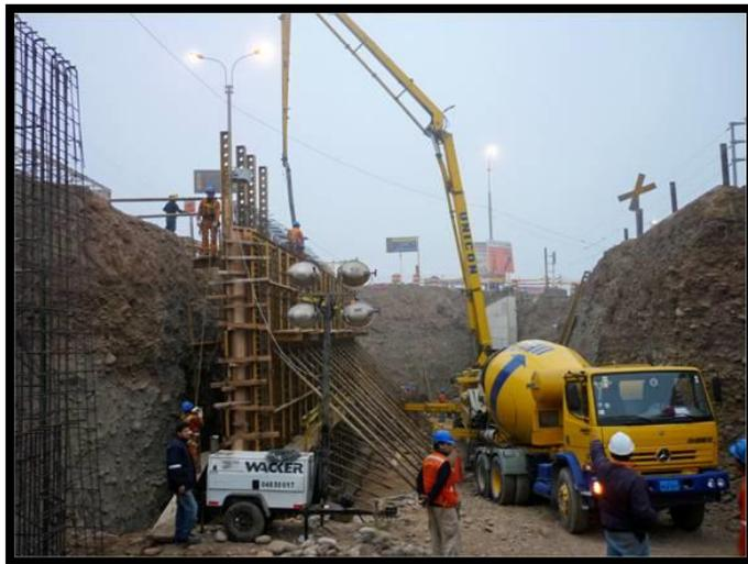
Figura 15. Concreto bombeado.
