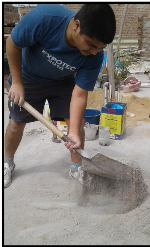
Figura 107. Mezclado en seco de los agregados, la cal y el cemento, antes de echar el agua.
