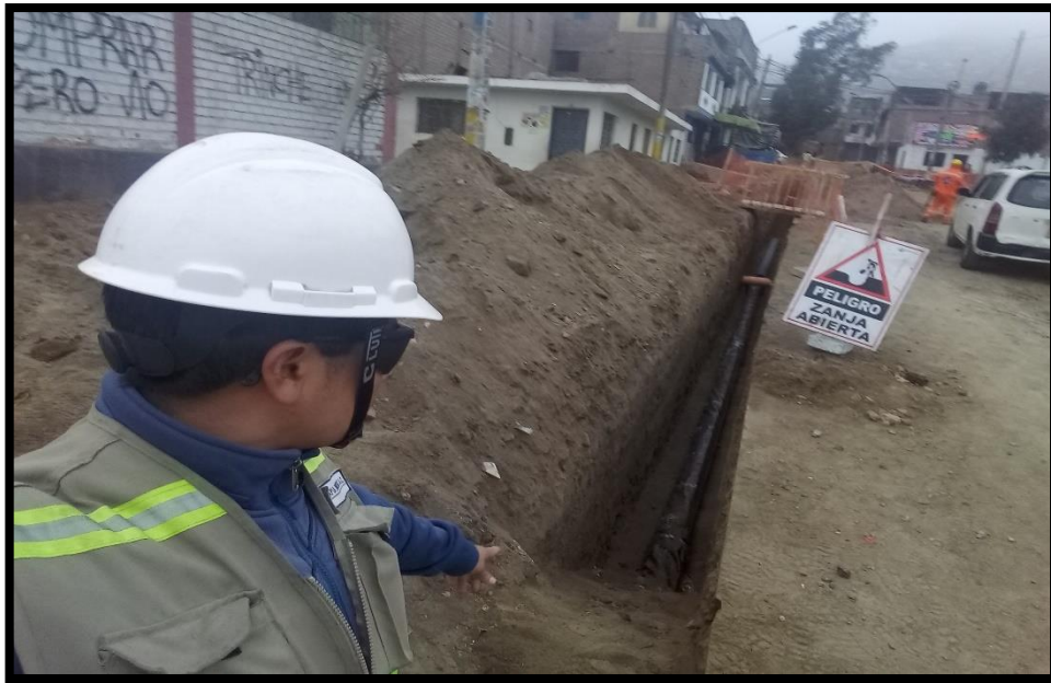
Fotografía N° 07: Vista del colector Ampliación Bayovar, listo para ser rellenado en capas de 30cm, vemos a un lado el material propio.
