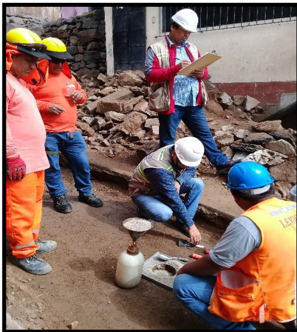
Fotografía N° 09: Vista del ensayo de cono de arena para controlar la máxima compactación, el objetivo es obtener más del 95% de grado de compactación.
