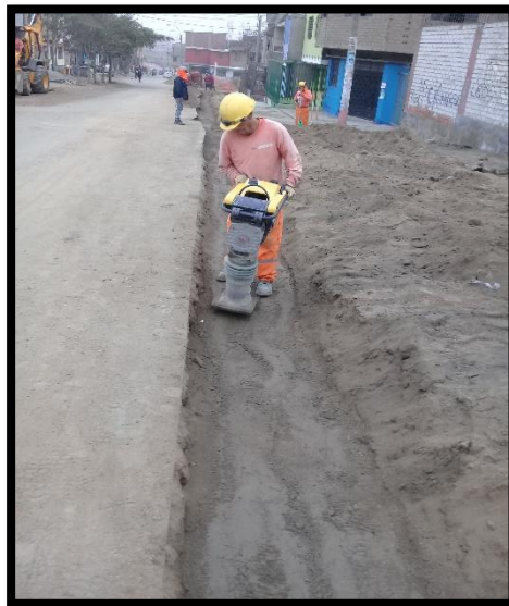
Fotografía N° 07: Vista del colector Ampliación Bayovar, listo para ser rellenado en capas de 30cm, vemos a un lado el material propio.
