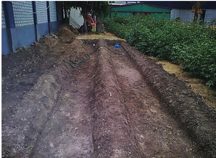
Figura N°23, Construcción de las camas composteras.
