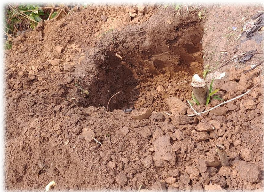
Foto N° 02: Realización de la calicata para la toma de muestra.
