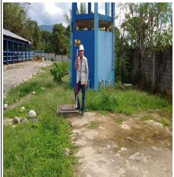
Caja de registro de reservorio.
