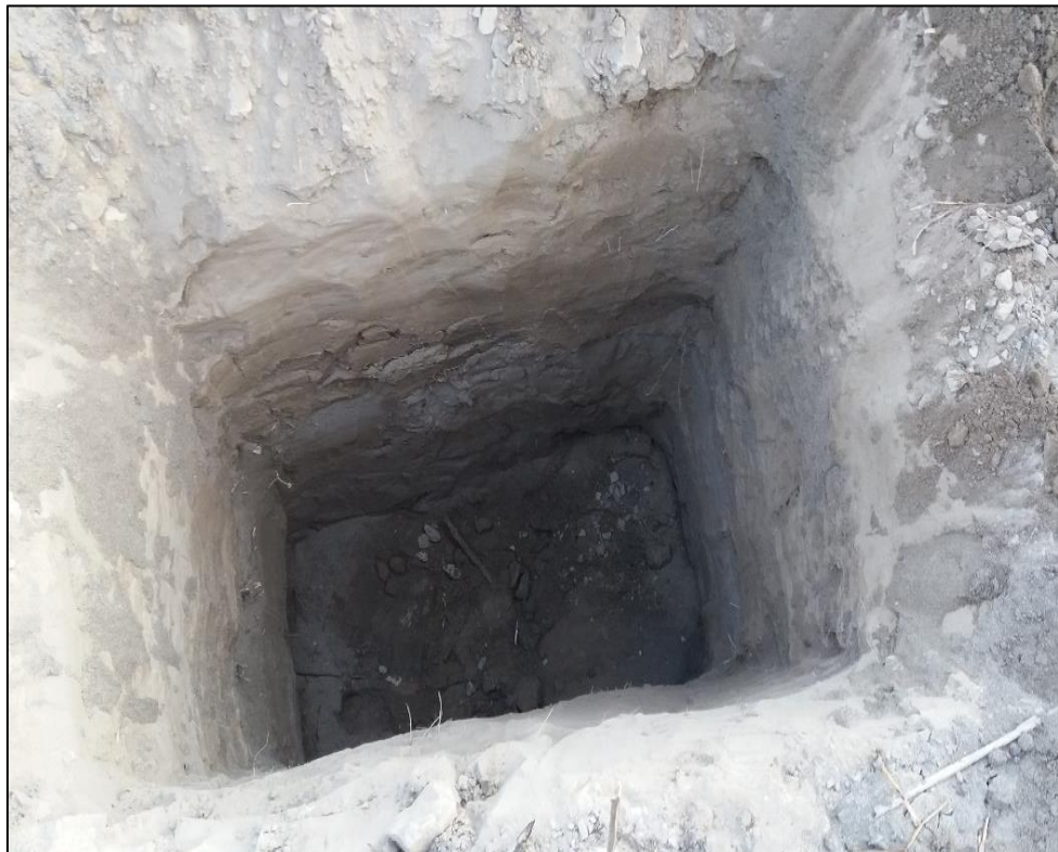
Figura 19. Excavación de calicata N° 03.
