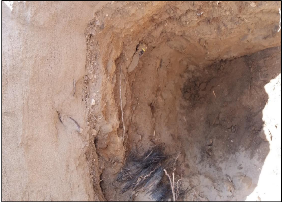
Figura 24. Excavación de calicata N° 06.
