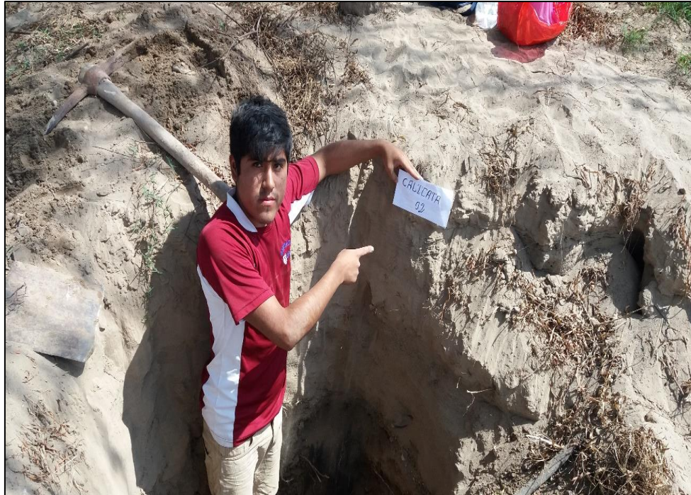
Figura 18. Verificación de trabajos de excavación de calicata N° 02.
