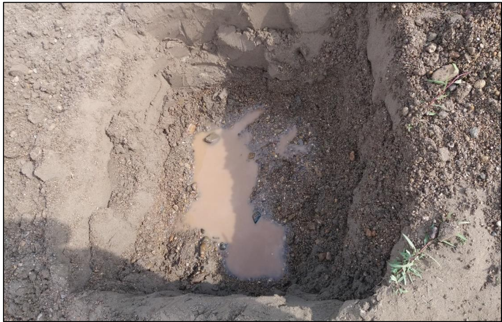
Figura 16. Se observa la presencia del nivel freático en la calicata N° 01.
