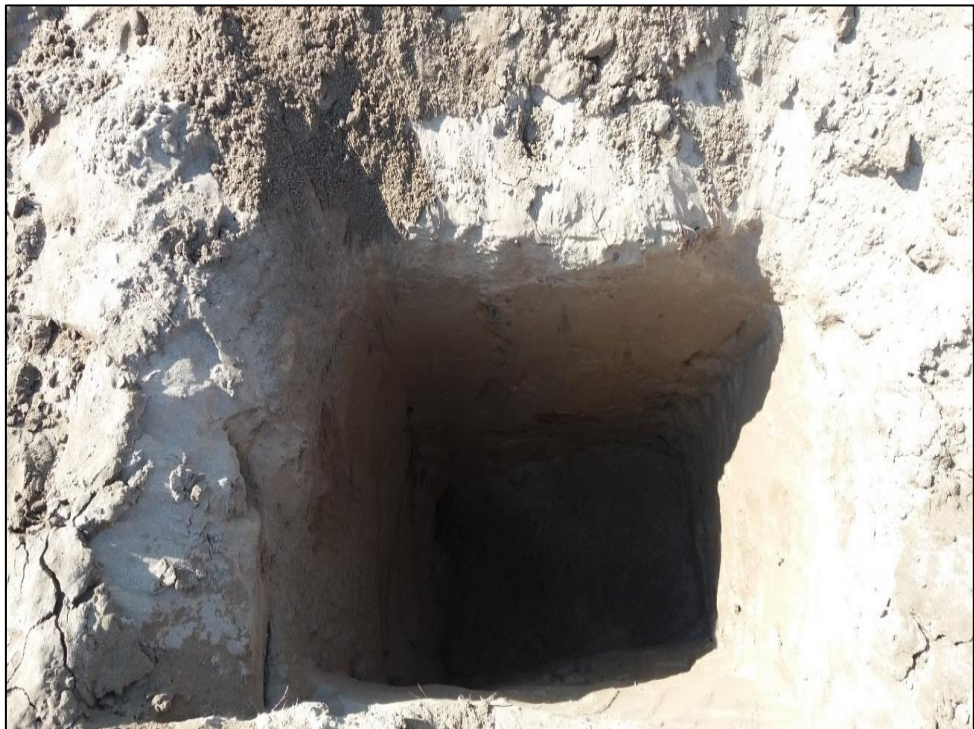
Figura 21. Excavación de calicata N° 04.
