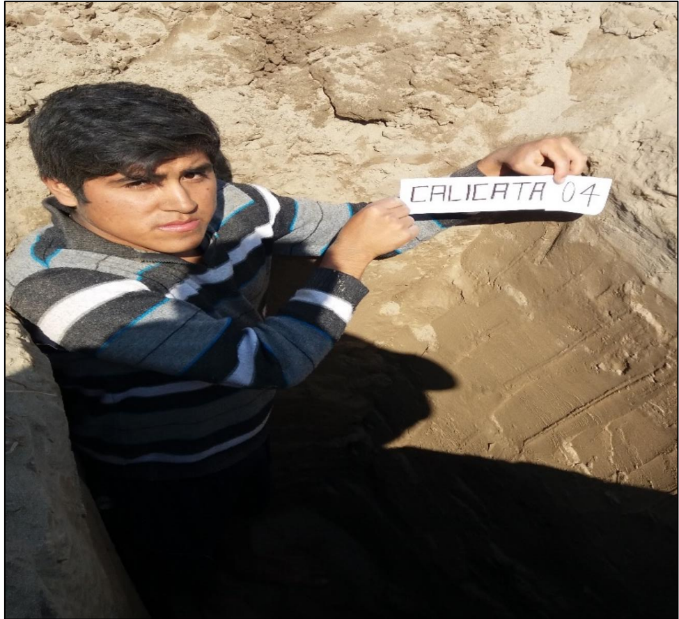
Figura 22. Verificación de trabajos de excavación de calicata N° 04.
