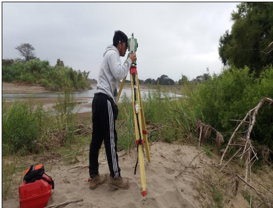
Figura 13. Se observa al topógrafo en el registro de coordenadas UTM.
