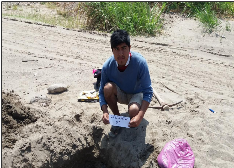
Figura 17. Verificación de trabajos de excavación de calicata N° 01.
