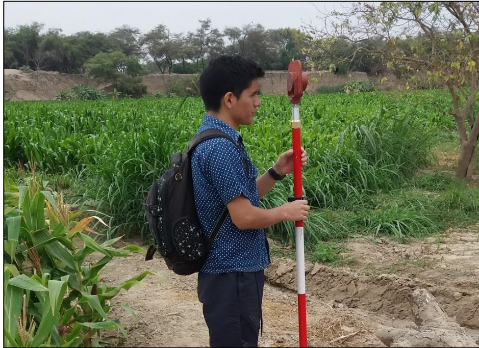
Figura 14. Se observa al asistente topográfico en con el prisma en el registro de coordenadas UTM.
