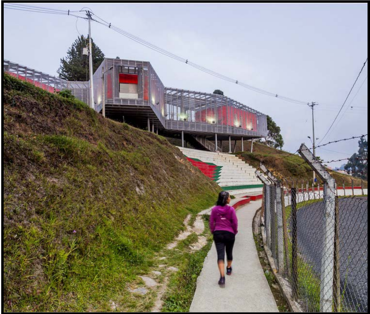
Figura 10: Fachada del parque Marinilla, recuperado de: http://www.archdaily.pe/pe/785036/parque-educativo-de-marinilla-el-equipo-de-mazzanti/5704650ee58ece36490002c7-parque-educativo-de-marinilla-el-equipo-de-mazzanti-foto
