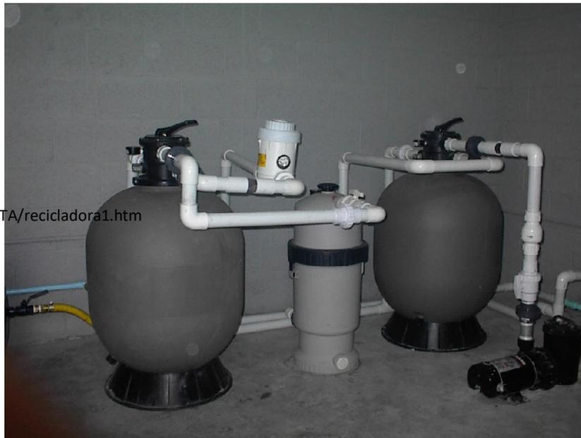
Figura 4: Sistema de bombeo, filtro de arena, filtro de diatomáceas, filtro de carbón y clorador
