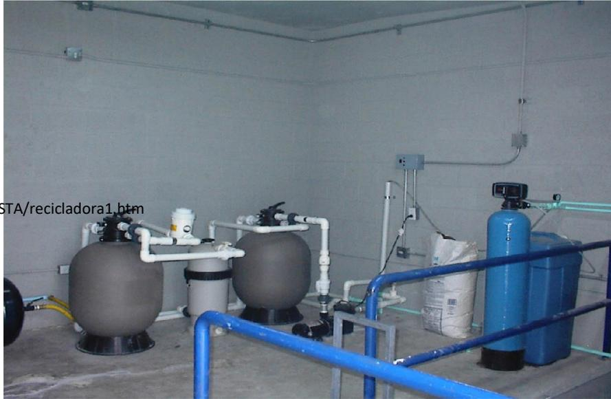
Figura 3: Sistema de ablandamiento y de filtración
