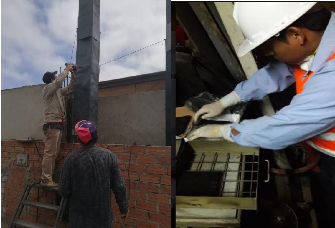
Fotografía N° 5.- Instalación del filtro
