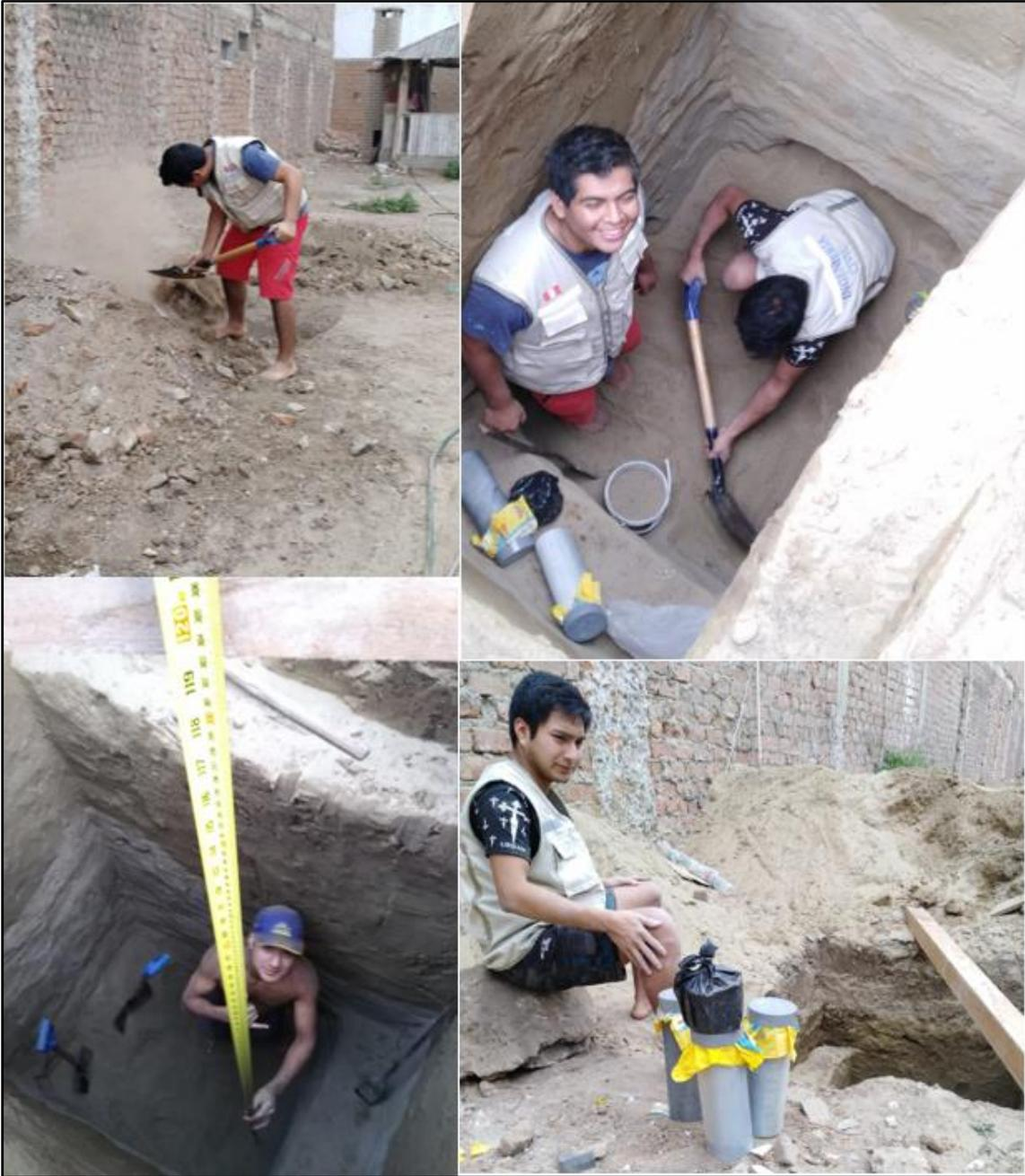
Figura 18. Trabajo de campo para el estudio de mecánica de suelos.
