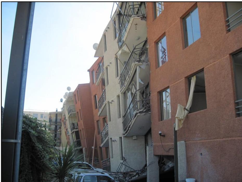
Figura 10. Deformaciones en edificaciones de albañilería.
