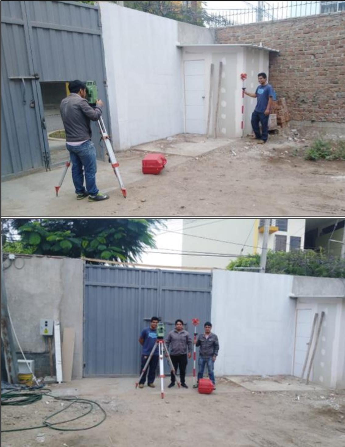
Figura 18. Levantamiento topográfico del terreno con estación total
