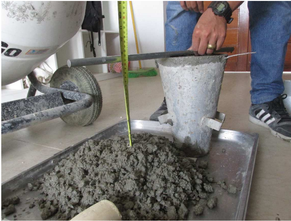
Figura 87. Asentamiento del primer diseño de mezcla de concreto.
