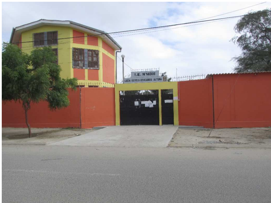
Figura 141. Fachada de la I.E. 14005 Lucía Estela Echeandía Altuna, ubicada en el Jirón I.
