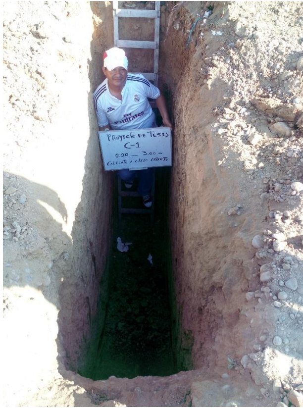
Perforación de la calicata 01
