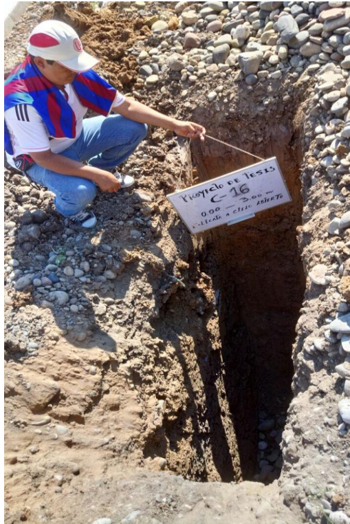
Perforación de la calicata N° 16
