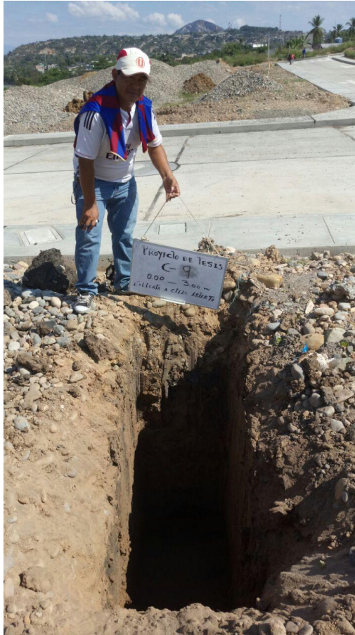
Perforación de la calicata N° 09
