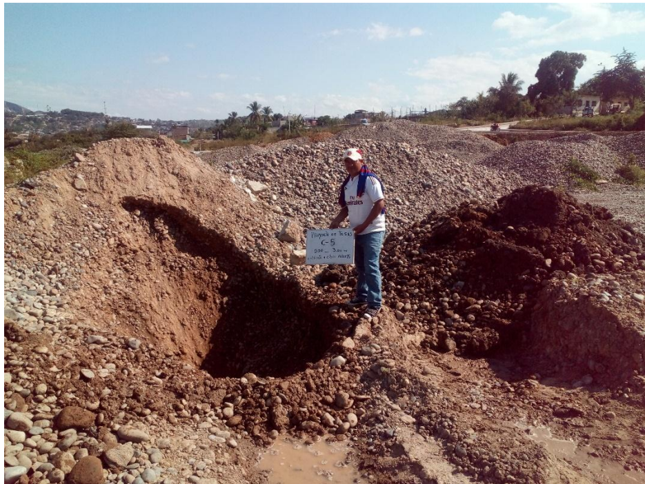
Perforación de la calicata N° 05 a cielo abierto
