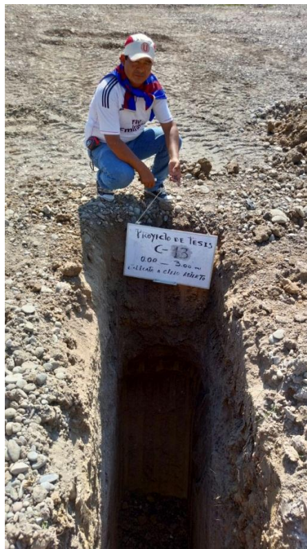
Perforación de la calicata N° 13
