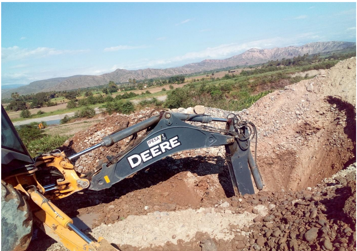
Perforación de calicata cerca a la ladera del río Utcubamba
