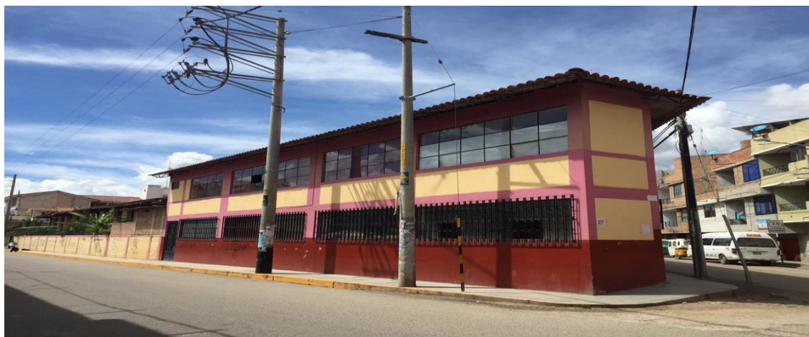
Figura 7 Vista Frontal de Edificación, Cajamarca
