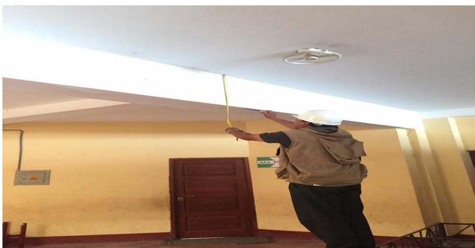
Figura 103. Realización medida de peraltes de viga
