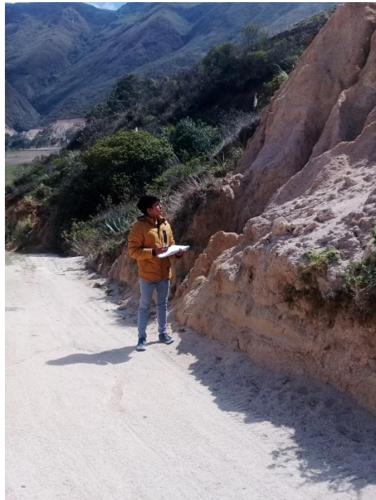
Figura 8: Presencia de Roca granodiorita fracturada
