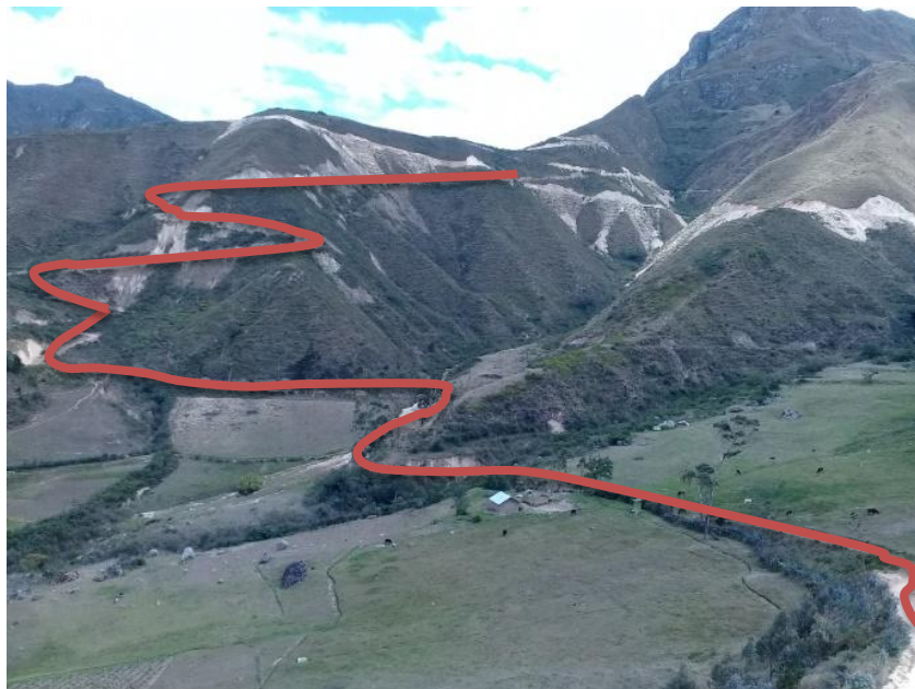
Figura 22. Acceso al túnel proyectado
