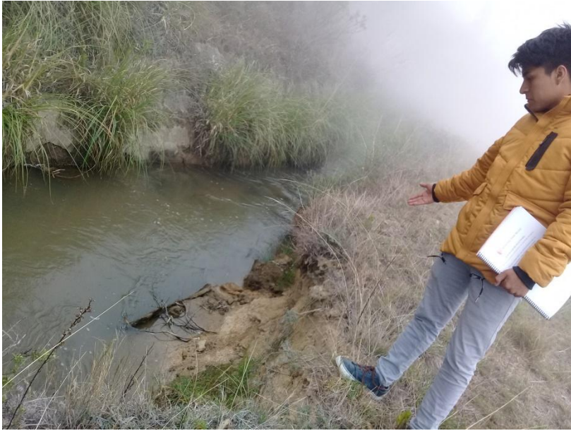
Figura 27. Observación del canal roto
