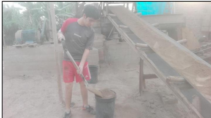
*Figura 32.* Llenado de material de cantera en baldes de volumen de 0.042 m<sup>3</sup>
