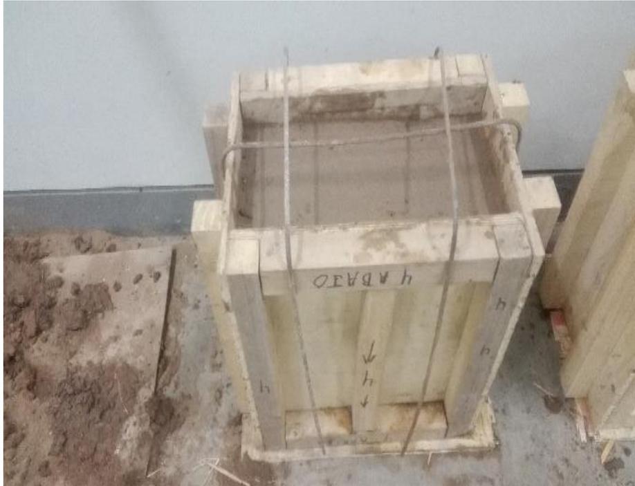
*Figura 109.* Colocación de acero de 3/8 para presionar el encofrado
