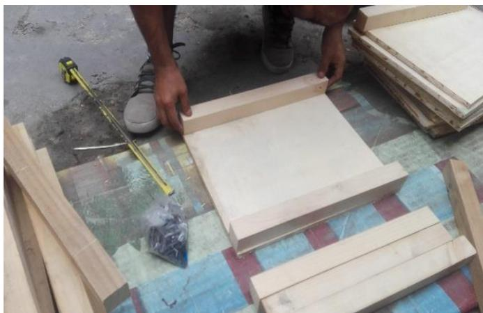
*Figura 40.* Proceso de armado de encofrado
