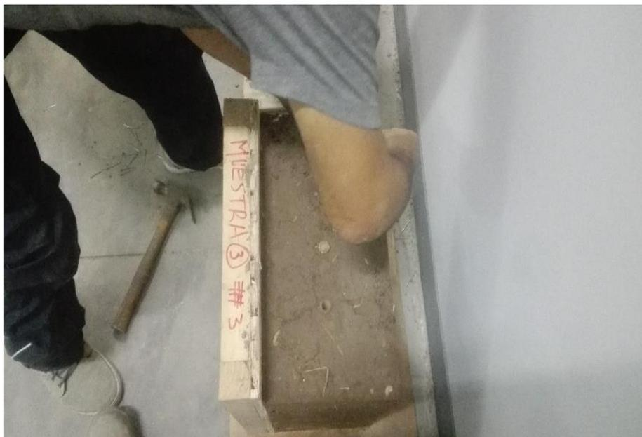
*Figura 122.* Desencofrado de muestras de tapial
