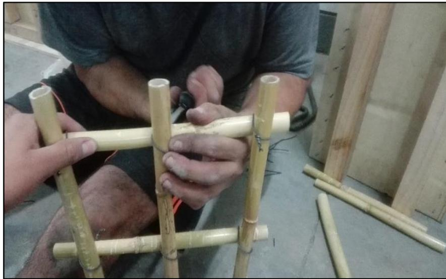
*Figura 97. Ajustes con alicate en las intersecciones de la malla de carrizo*
