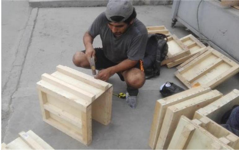
*Figura 103.* Uniones de caras laterales y frontales de encofrado
