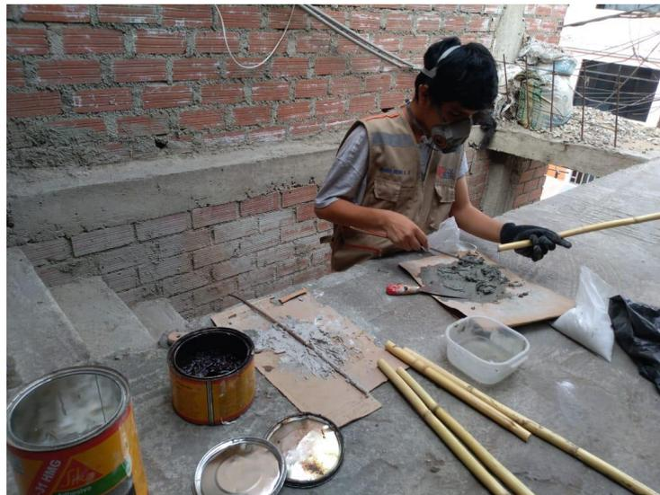
*Figura 48.* Introducción del epóxico en el interior del carrizo
