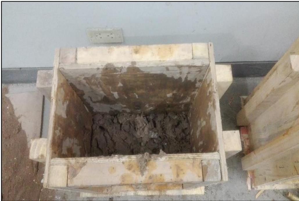
*Figura 107.* Vaciado de mezcla en el primer encofrado
