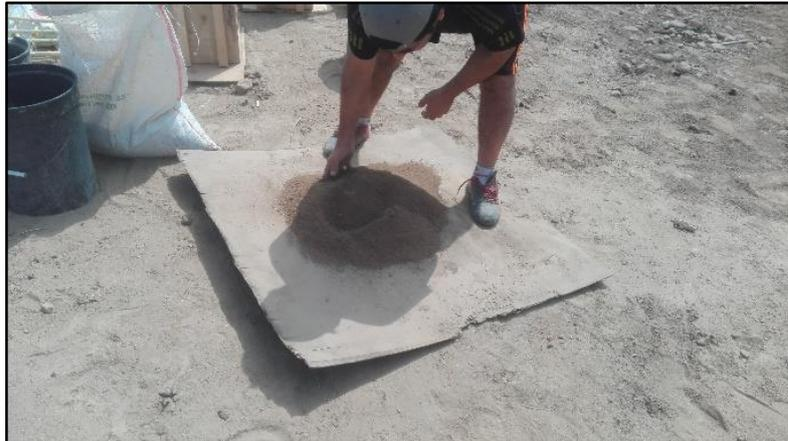
*Figura 84.* Mezcla de agregados en un triplay de 1.5 x 1.5 m2
