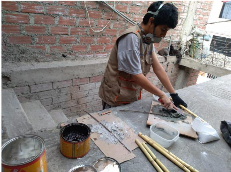
*Figura 45.* Preparación de la mezcla cemento más yeso
