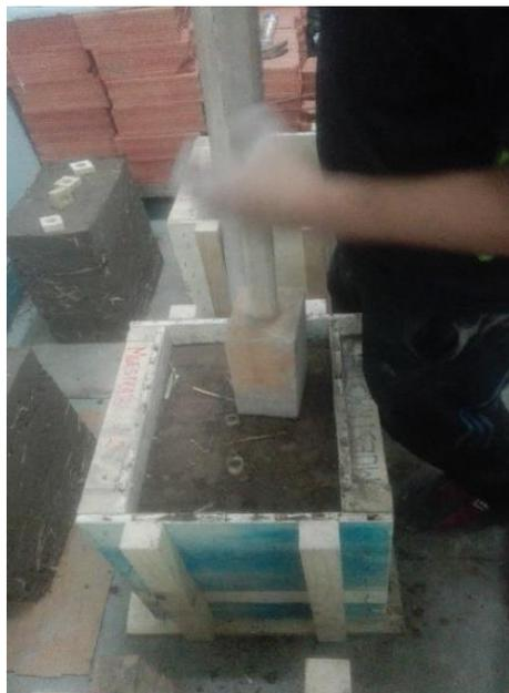
Figura 162. Apisonamiento en la última capa del 3° murete de  $e=0.25\text{m}$
