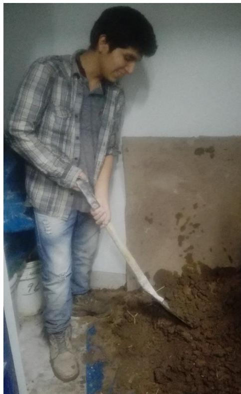
*Figura 140.* Proceso de mezclado para el dormido de la tierra
