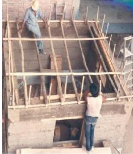
*Figura 13.* Estructura de tierra reforzada
