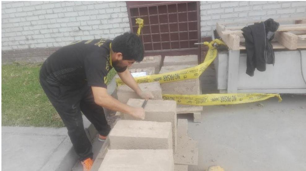
*Figura 127.* Nivelando el tapial sin refuerzo
