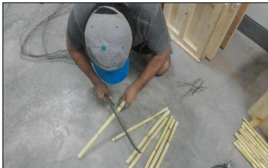
*Figura 96.* Corrugando las varillas de carrizo de 3/4" de diámetro
