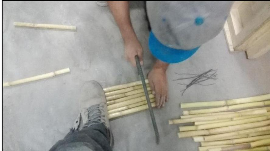
*Figura 95.* Corte y nivelación en las varillas de carrizo de 3/4" de diámetro
