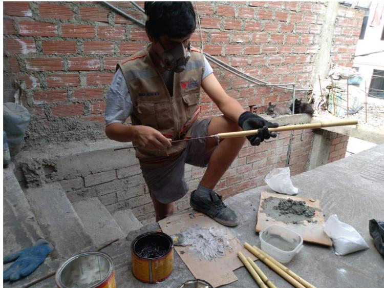
*Figura 47.* Introducción del cemento más yeso en el interior del carrizo
