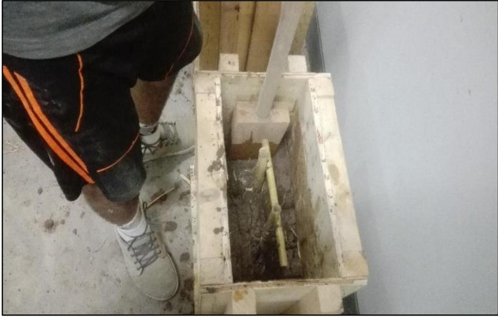
*Figura 111.* Apisonamiento en la segunda muestra de tapial
