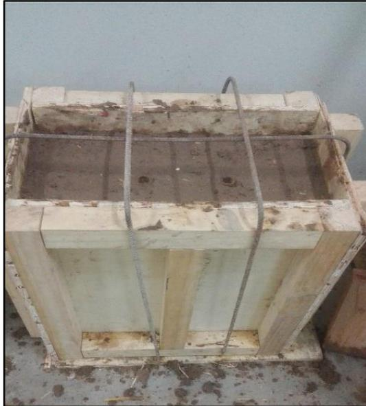
*Figura 113. Colocación de acero de 3/8 para presionar el encofrado*
