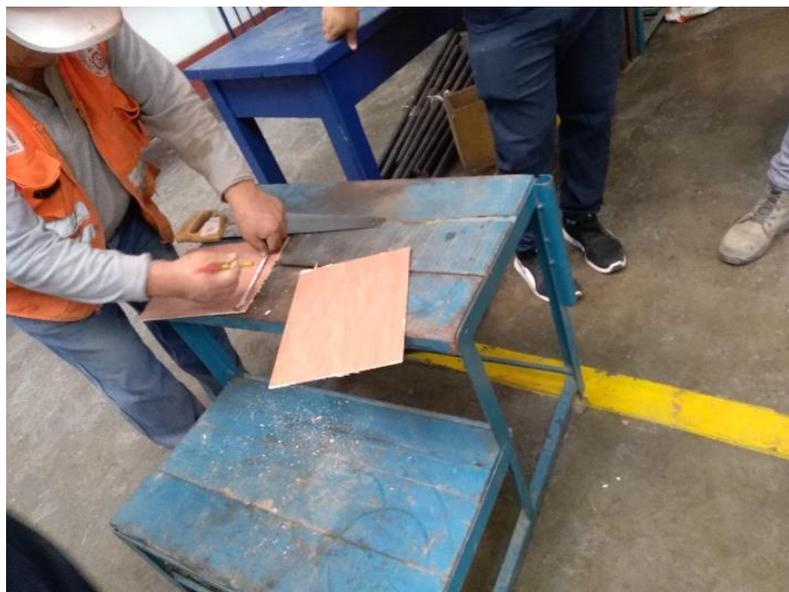
*Figura 176. Elaboración de piezas de triplay para los apoyos del murete*
