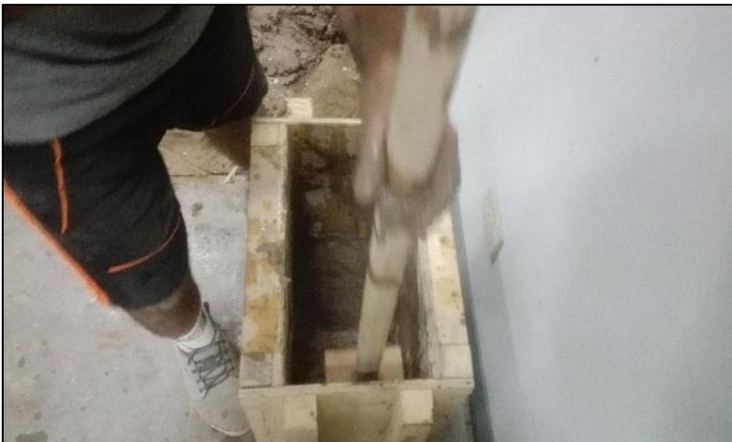
*Figura 108.* Apisonamiento en la primera muestra de tapial
