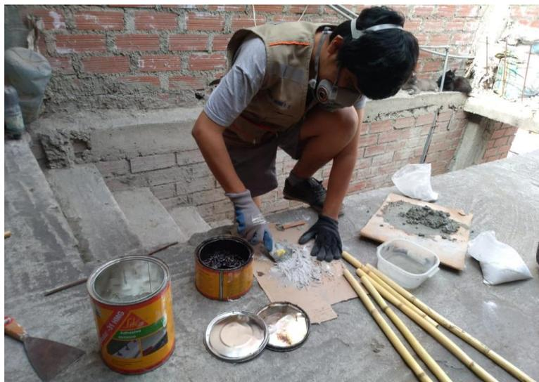
*Figura 46.* Preparación de la mezcla del epóxico
