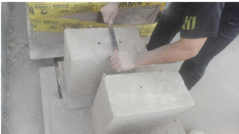
*Figura 128.* Nivelando el tapial con refuerzo de carrizo
