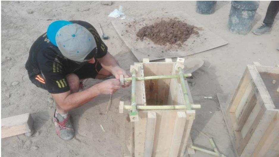
*Figura 89.* Tapial con ancho de 20 cm con malla de #2 carrizos
