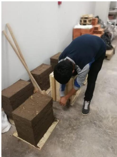
*Figura 168.* Desencofrado de las caras frontales con martillo de carpintería
