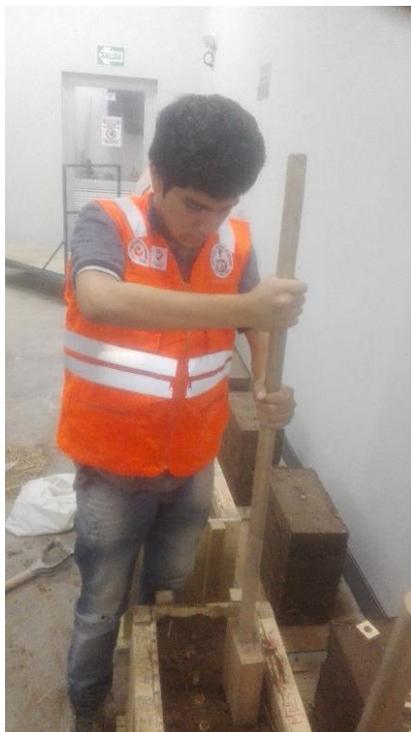
*Figura 164.* Apisonamiento en la última camada del 4 murete de  $e=0.25\text{m}$
