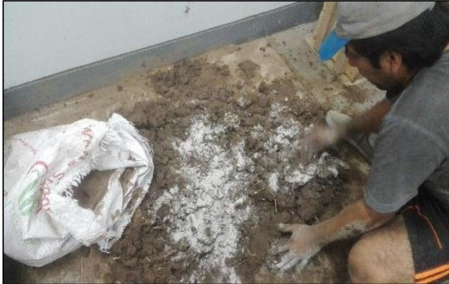
*Figura 105. Mezcla de la tierra con el aditivo de cal*
