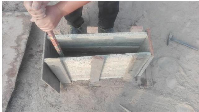
*Figura 76.* Encofrado de primera prueba
