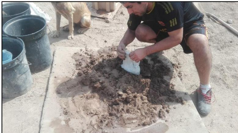
*Figura 85.* Vaciado de cal con un 5% en la mezcla
