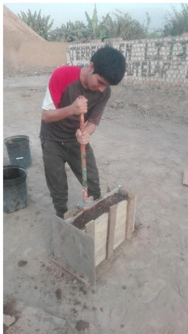
*Figura 77.* Apisonamiento de primera prueba
