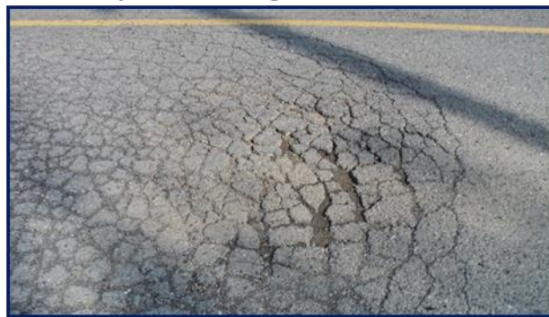
Figura 2: Falla tipo Piel de cocodrilo
