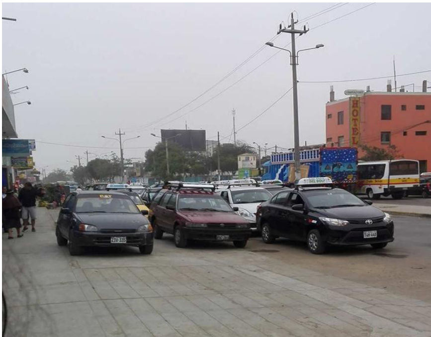
Figura 95. Daños a las calzadas.
