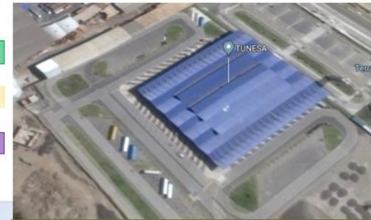
ZONA OPERACIONAL INTERNA, VISTA AEREA
