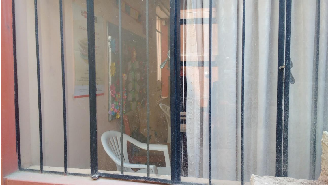
Ilustración14: Ventanas de vidrio y con cortinas entre ambientes
