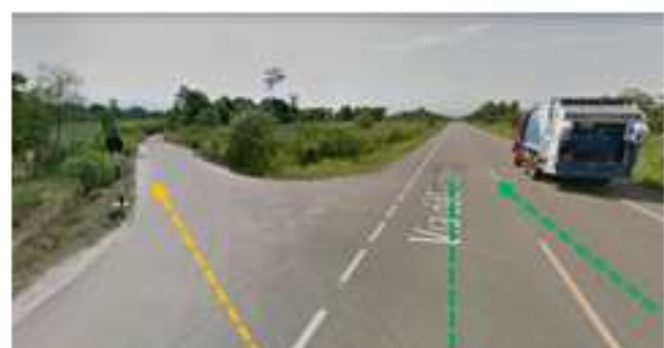
Via principal de Acceso Trocha Carrozable Oasis.
