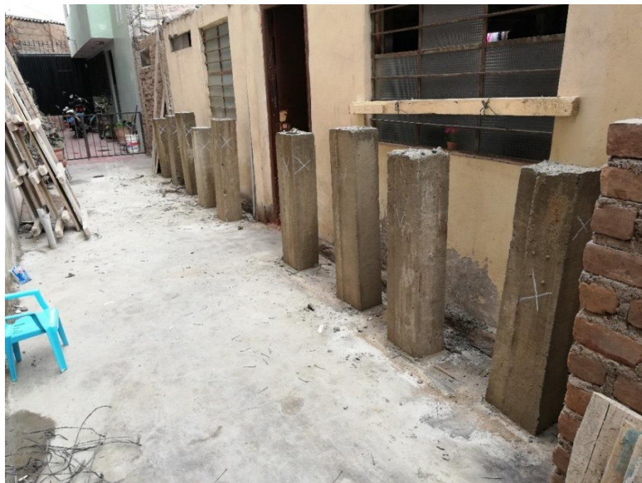
Fotografía 33.- Presentación de las columnas construidas completamente desencofradas Origen: Propio
