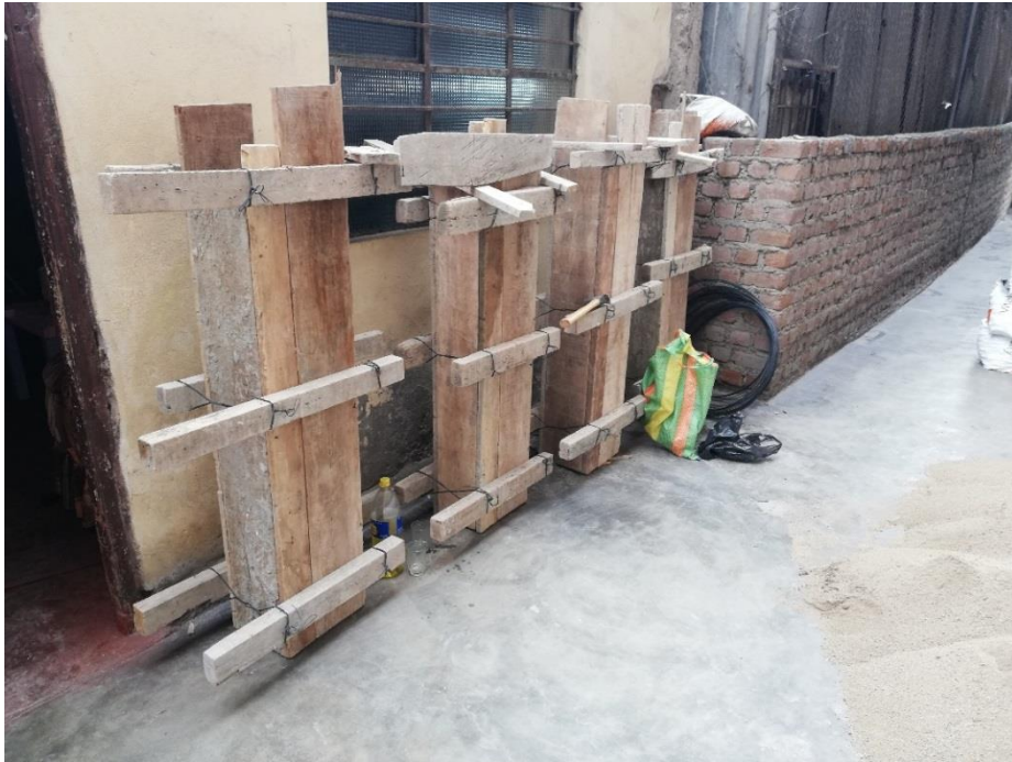
Fotografía 12.- Ubicación de los encofrados de madera Origen: Propio
