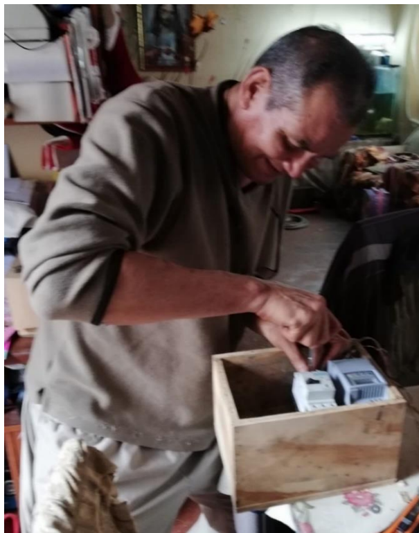
Fotografía 4.- Conexión del cableado al Guardamotor o relé. Origen: Propio
