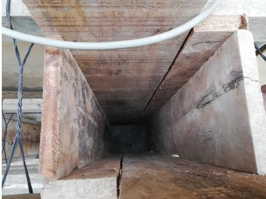
Fotografía 14.- Vista interna de un encofrado Origen: Propio
