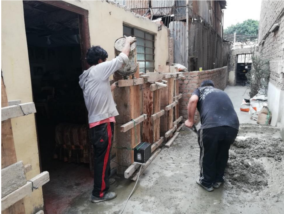
Fotografía 22.- Colocación del concreto al encofrado. se puede notar ya el funcionamiento del dispositivo vibrador en la parte inferior del encofrado
