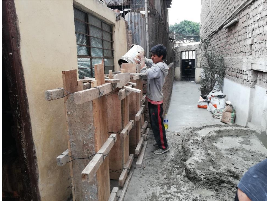
Fotografía 20.- Vaciado del concreto al encofrado Origen: Propio
