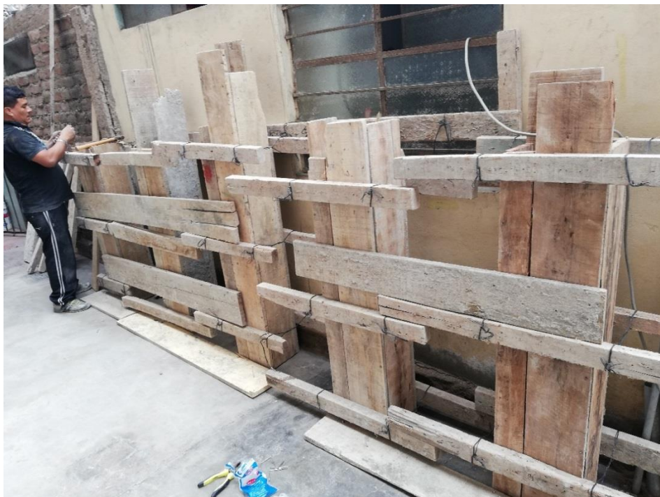
Fotografía 13.- Amarrado de los encofrados Origen: Propio
