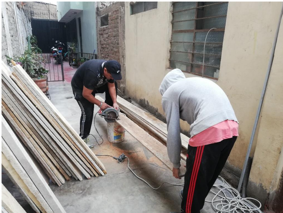
Fotografía 7.- Corte de madera para el encofrado. Origen: Propio
