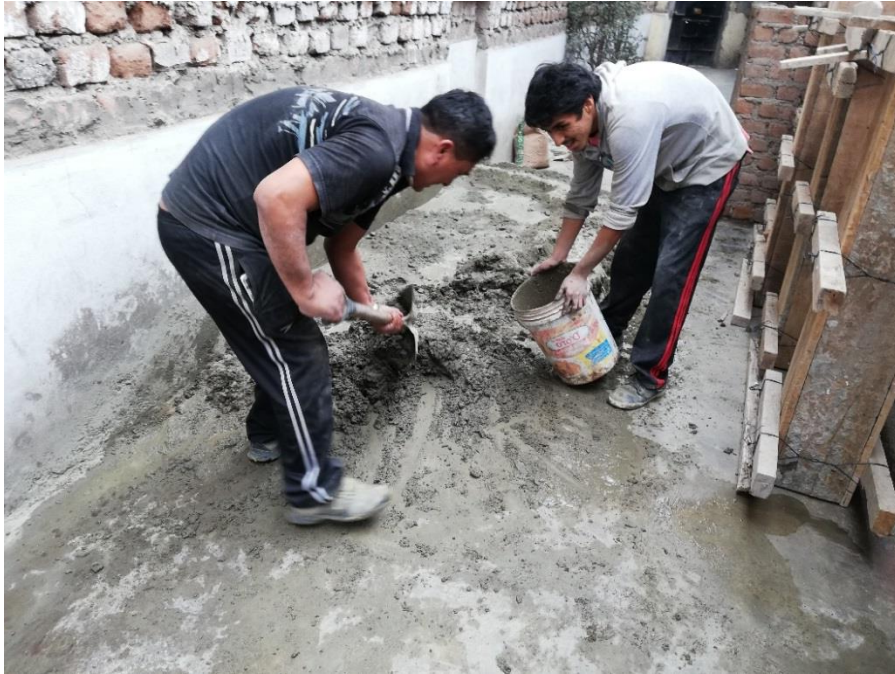
Fotografía 18.- Mezcla y colocación del concreto fresco al balde Origen: Propio
