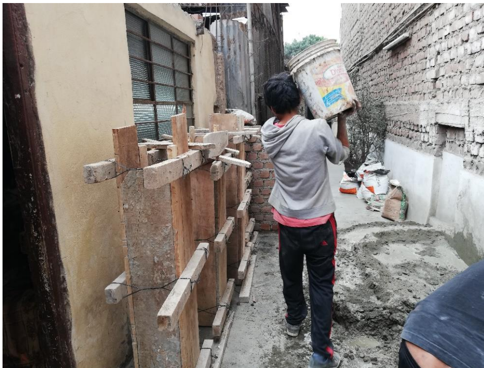
Fotografía 19.- Traslado del concreto al encofrado Origen: Propio
