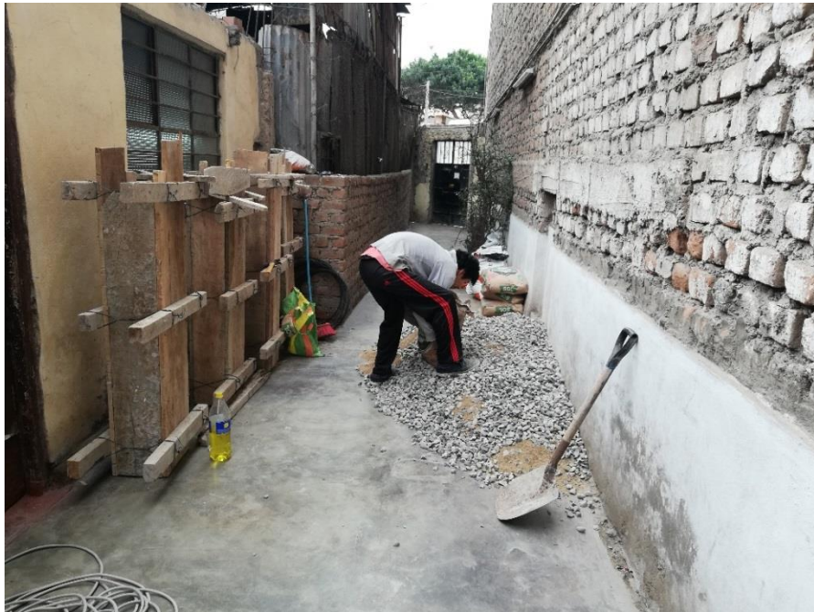
Fotografía 15.- Elaboración del compuesto del hormigon Origen: Propio
