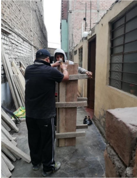
Fotografía 8.- Armado del Encofrado.
