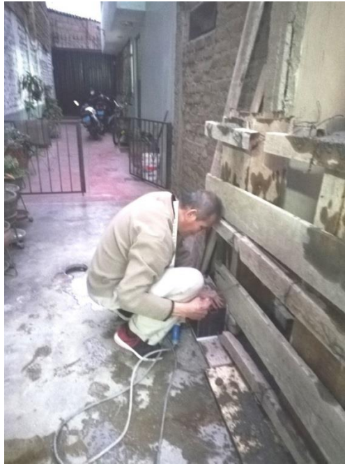
Fotografía 26.- Aseguramiento de la caja vibratora al encofrado Origen: Propio
