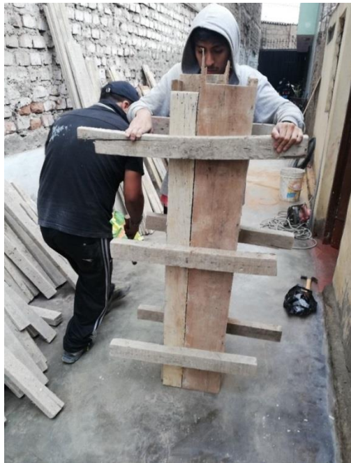
Fotografía 9.- Presentación de un encofrado.
