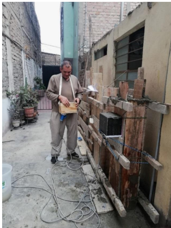
Fotografía 23.- Operación del dispositivo vibrador en la parte superior del encofrado
