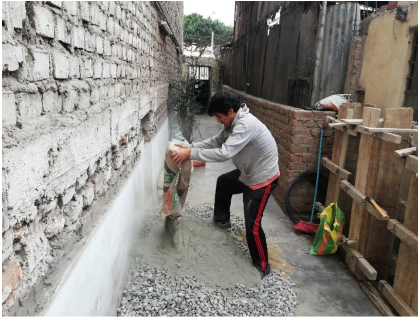
Fotografía 16.- Vaciado del Cemento al agregado del concreto Origen: Propio
