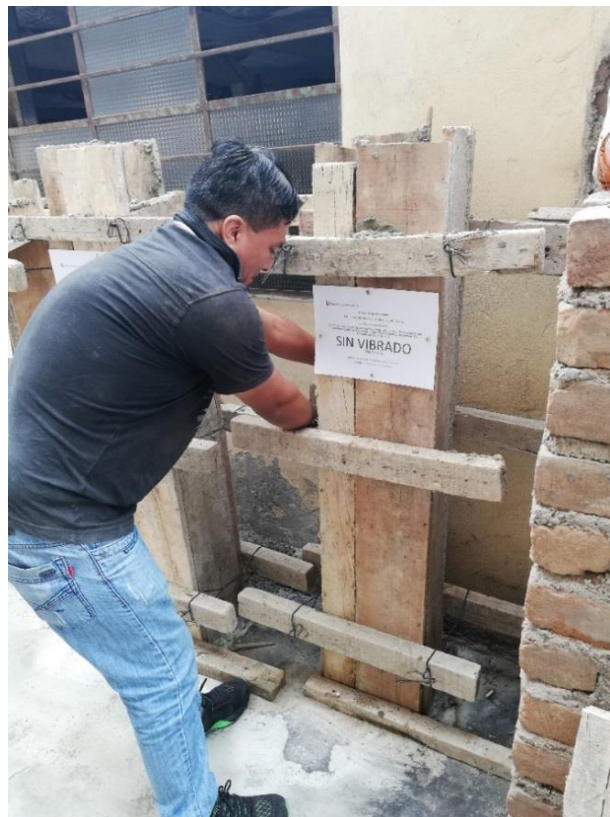
Fotografía 31.- Desencofrado de las columnas al día siguiente Origen: Propio
