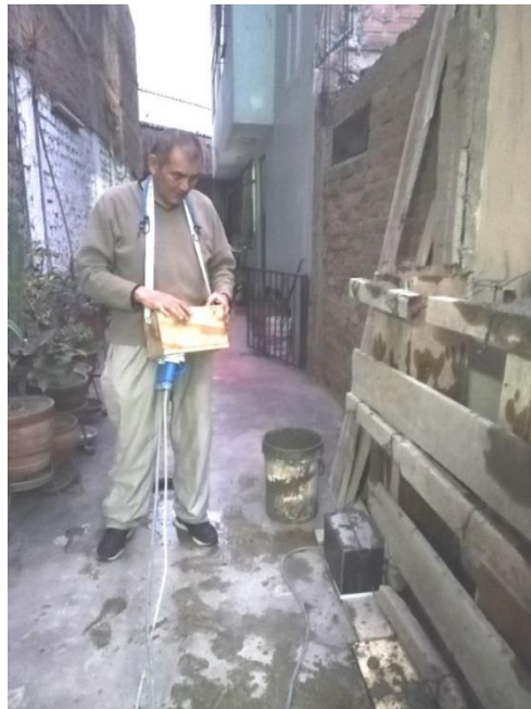
Fotografía 25.- Operación del dispositivo vibrador en el encofrado
