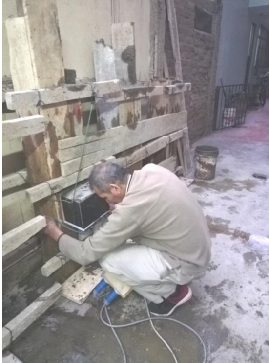
Fotografía 24.- Cambio de ubicación del dispositivo vibrador a otro encofrado para la colocación del concreto
