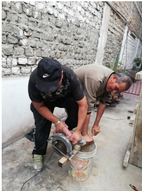
Fotografía 11.- Corte de listones para el armado del encofrado Origen: Propio
