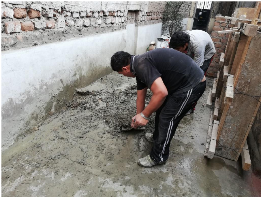
Fotografía 21.- Mezcla del concreto para ser colocado al encofrado Origen: Propio
