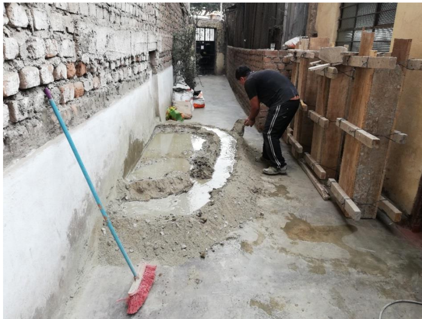
Fotografía 17.- Hidratación del compuesto del hormigon Origen: Propio
