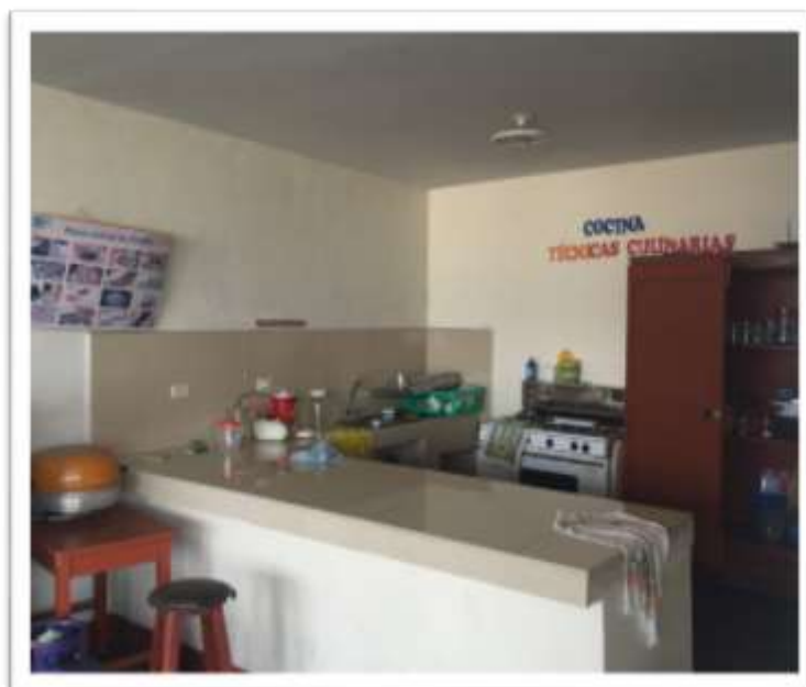
Figura 75. Taller de repostería no cuenta con las condiciones arquitectónicas necesarias
