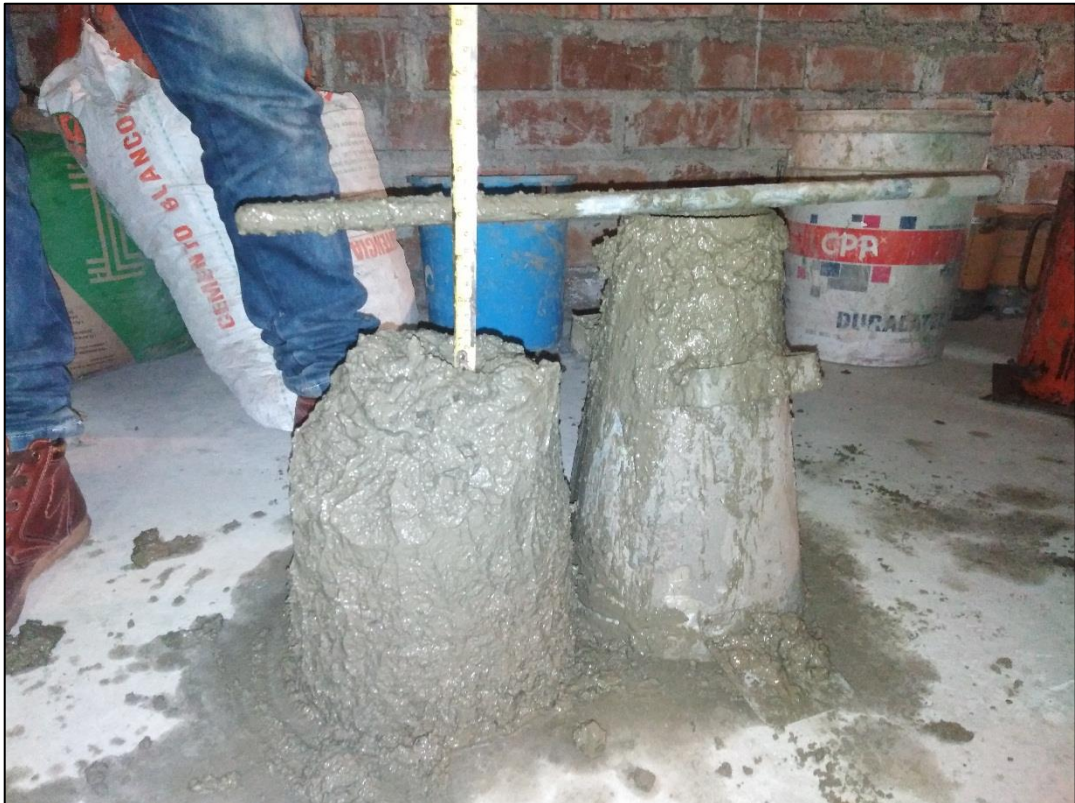
Figura. 43 Medición de asentamiento
