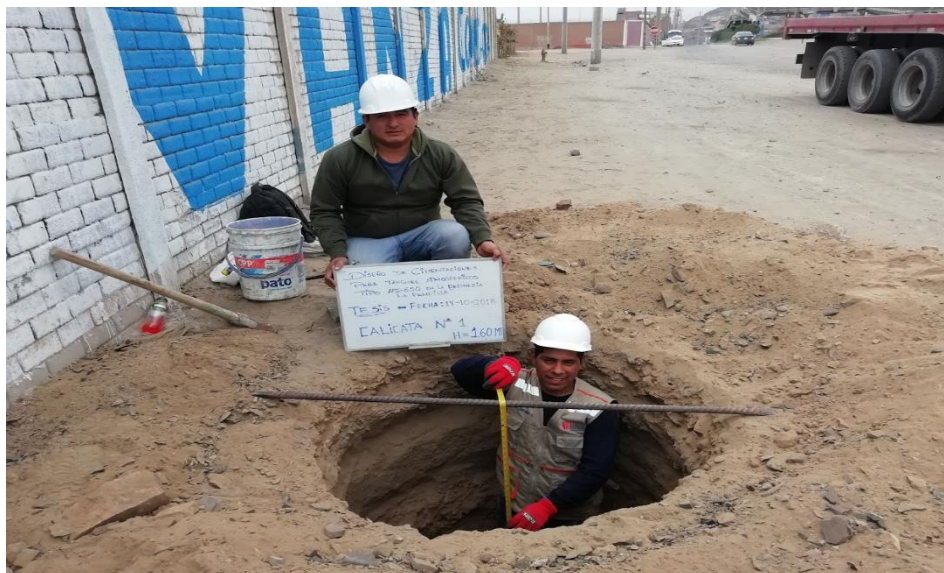
Figura 11: excavación a 1.60m para Obtener la muestra para el estudio
