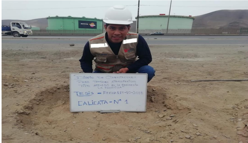
Figura10: Excavación para obtener la muestra para posterior estudio
