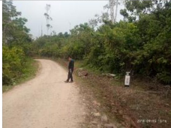
Imagen 16: Vista panorámica de la carretera Km. 8.0.
