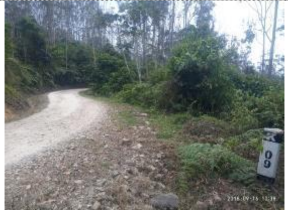
Imagen 17: Vista panorámica de la carretera Km. 9.0.
