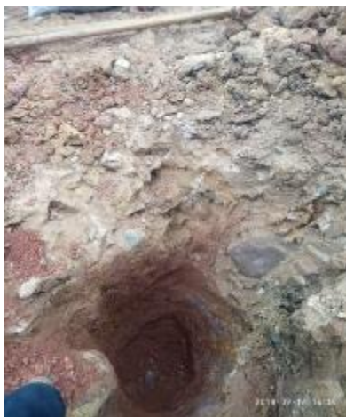
Imagen 22: Vista de la calicata.
