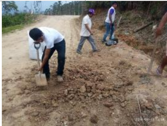
Imagen 26: Sellado final de la calicata.
