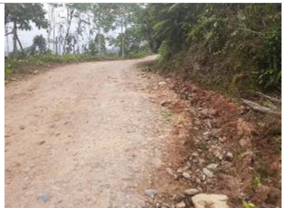
Imagen 15: Vista panorámica de la carretera Km. 6.2.
