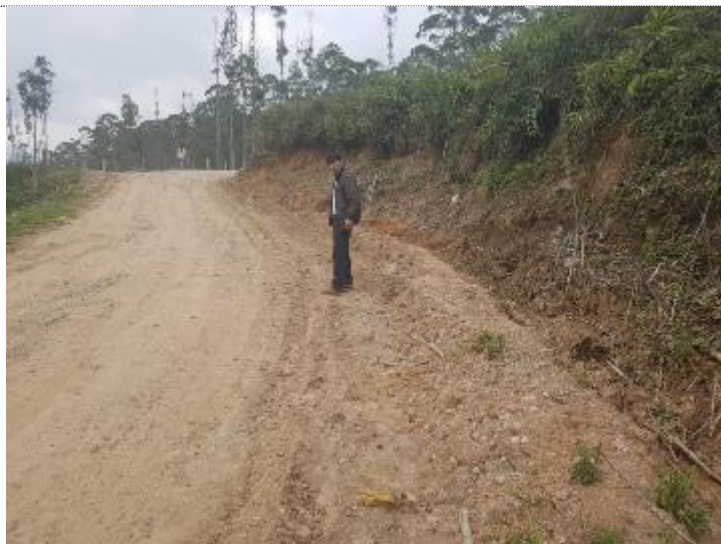
Imagen 18: Vista panorámica de la carretera Km. 8.5 - ubicación de la calicata.
