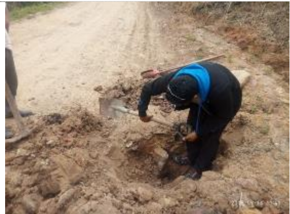
Imagen 21: Proceso de excavación.
