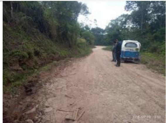
Imagen 13: Vista del estado de la carretera
