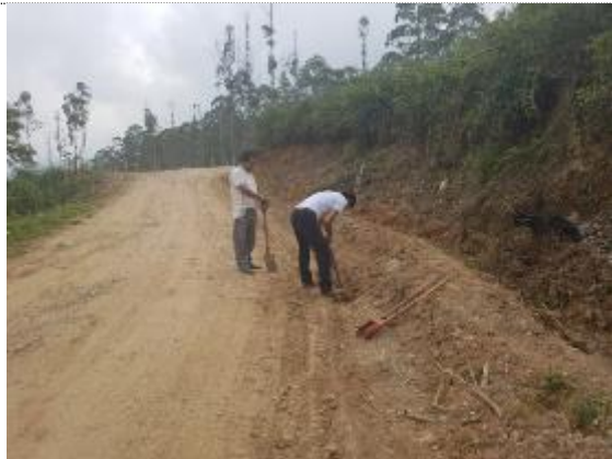
Imagen 20: Inicio de la calicata.
