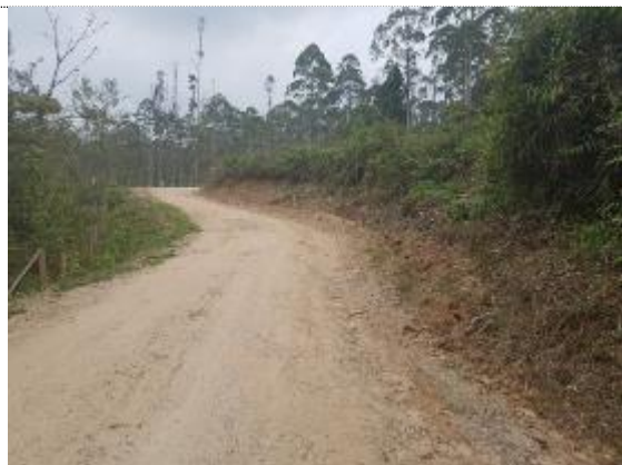
Imagen 14: Vista panorámica de la carretera Km. 8.5.
