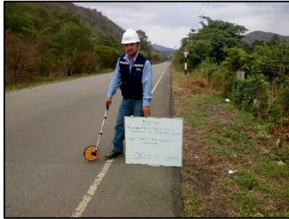
Foto1. Materiales e instrumentos utilizados en la elaboración del PCI.
