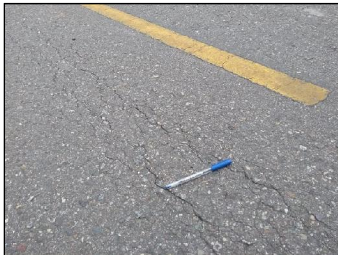
Foto2. Piel de cocodrilo de severidad media.
