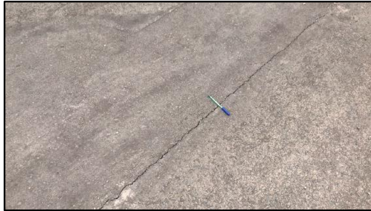
Foto 7. Fisura longitudinal
