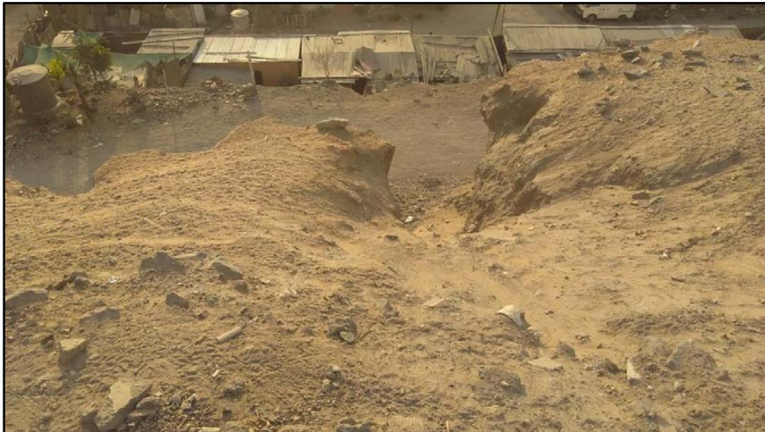
*Foto 7. Vista erosión de talud.*
