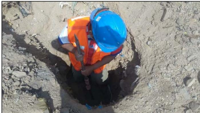
*Figura. 19: Excavación de Calicatas.*
