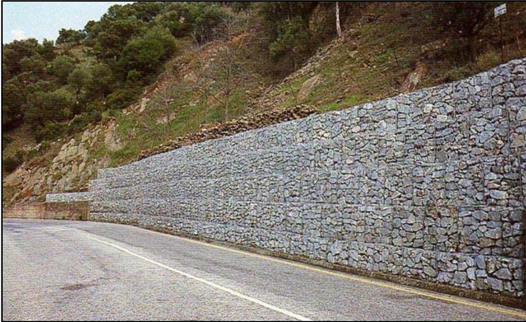
*Foto 11. Ejemplo de uso de gaviones en protección de vías. Maccaferri (2008).*
